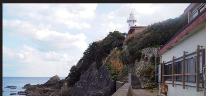
④ 大王埼灯台へのアプローチ（北から）：巨大な擁壁が空石積みで構成されている
