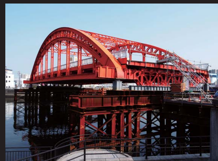
▲ 付け替え工事の中川橋（2016年2月撮影） この位置より手前へスライドさせて現在の位置へ移設された。 ▼ その際に普段見ることのできない橋梁の断面が見られた。
