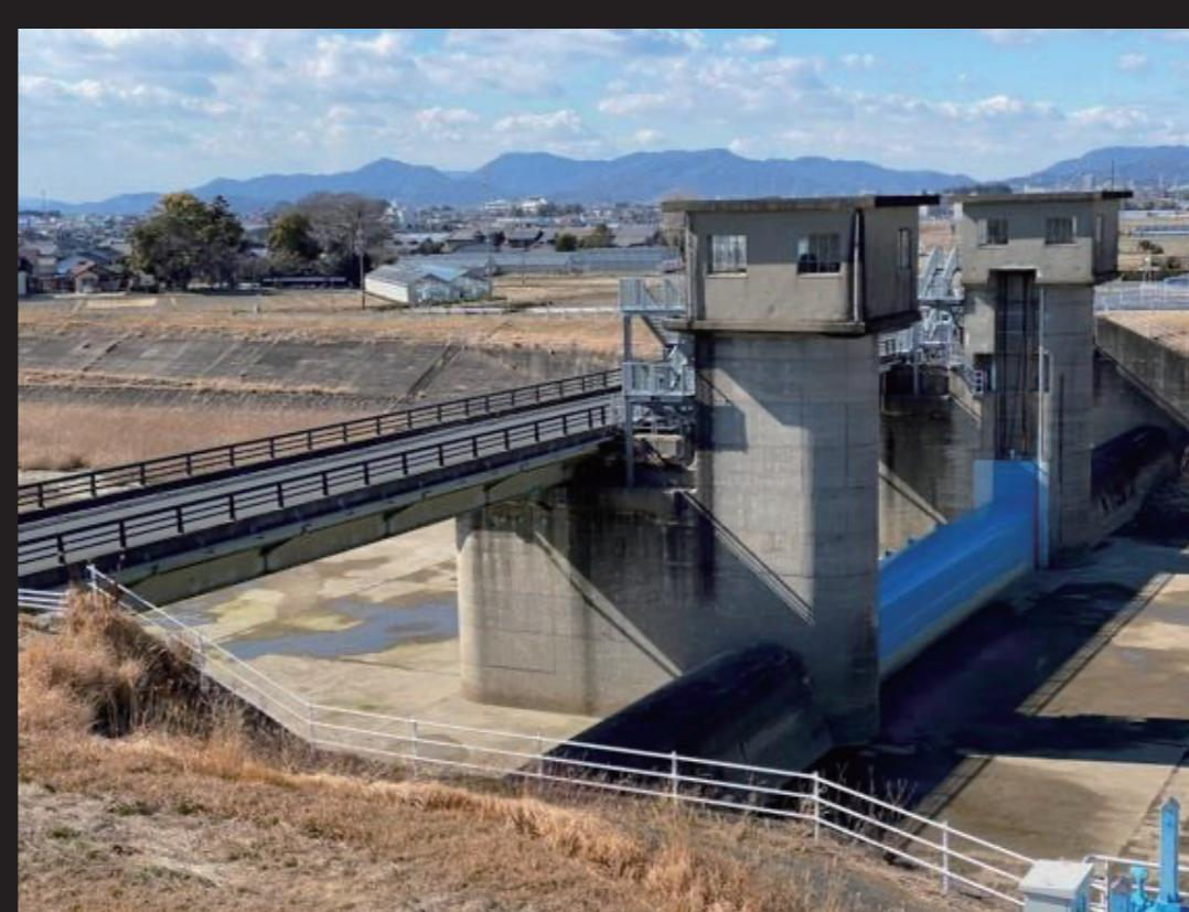
▲ 分流堰の現状。分流堰は当初固定堰を予定していたが、放水路の河床変動を考慮し、有効幅員95mのうち固定堰2スパン、可動堰1スパンの構成とし、可動堰には流水中のゲート昇降を考慮してD型シェル越流門扉を採用した。（筆者撮影）
