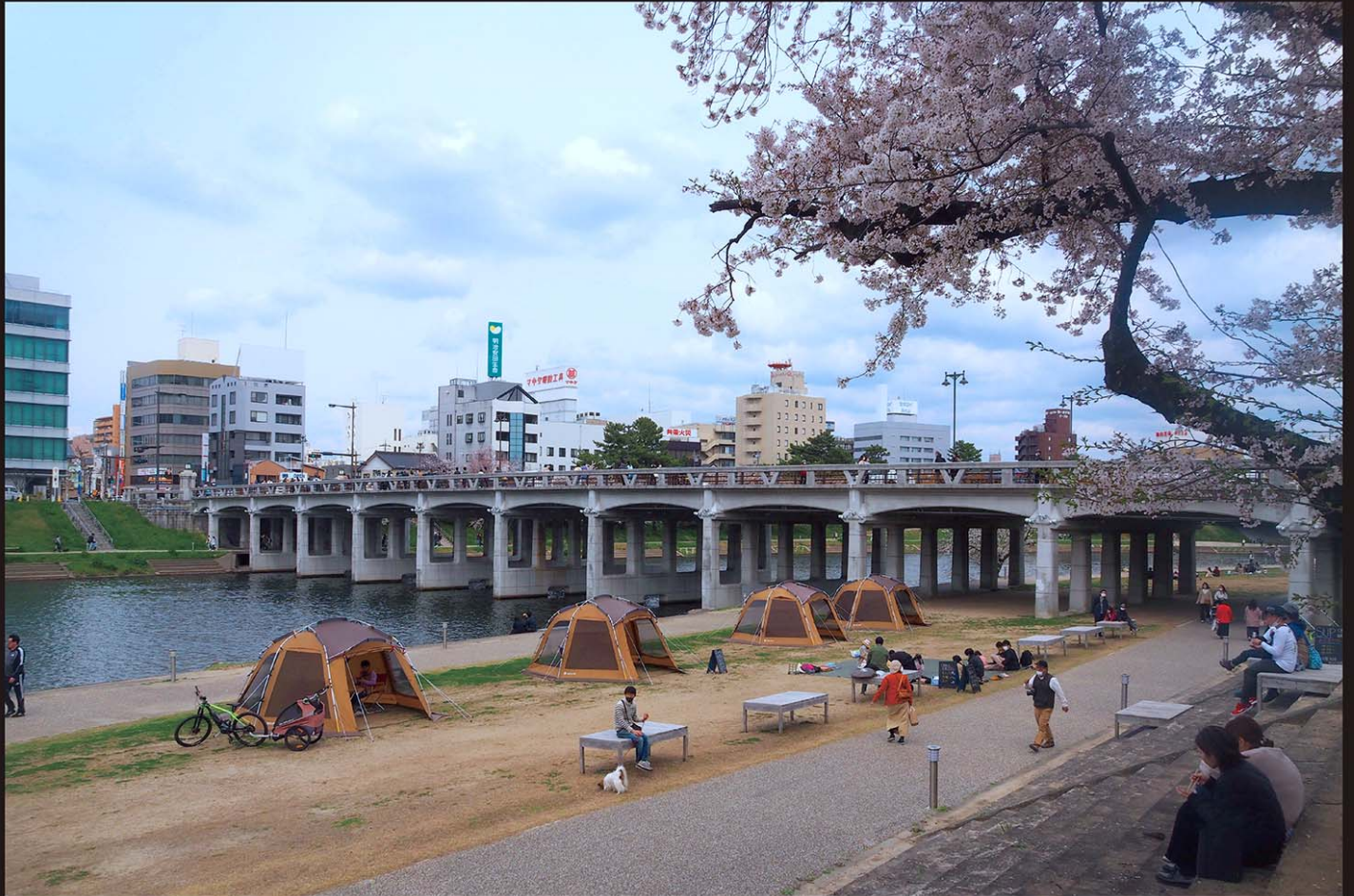
下流左岸側からみる殿橋の風景。橋の周りには憩いの場ができています。
