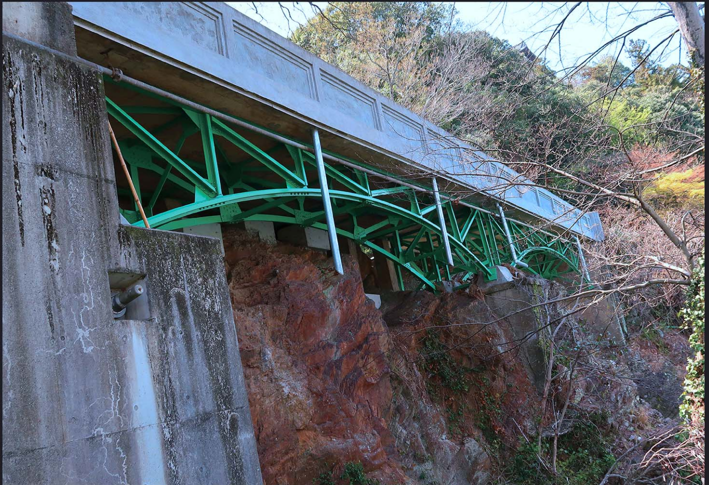
下側から見た彩雲橋。写真上方には犬山城天守の屋根が見える。
