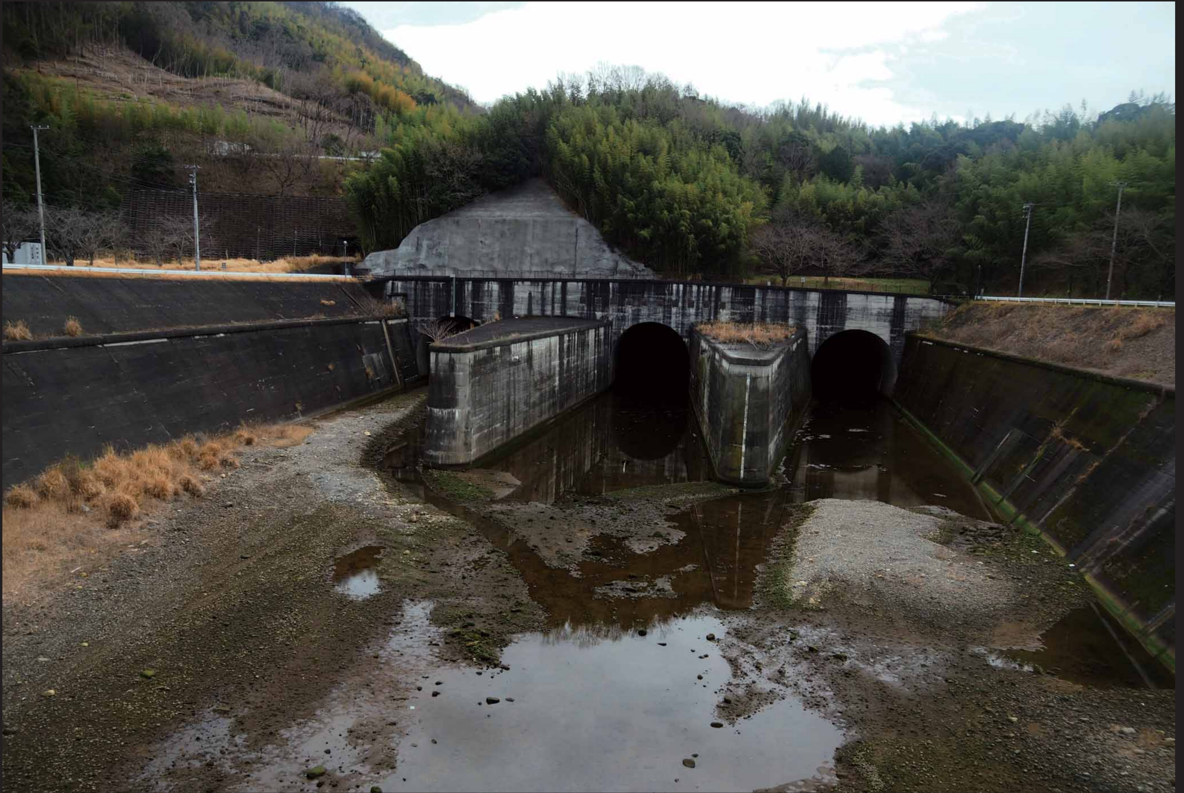
長岡トンネルの吐口下流からの風景。
