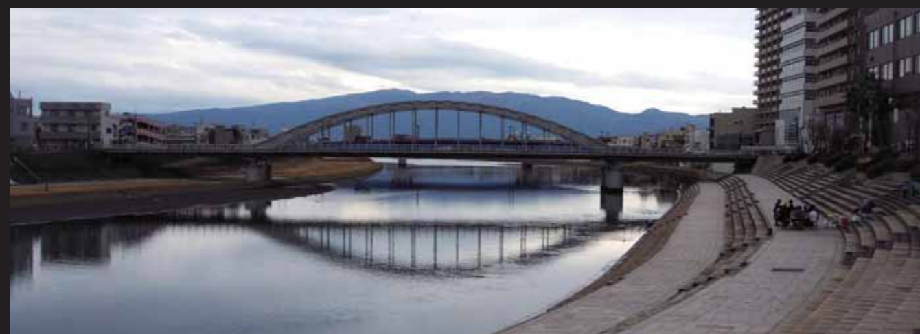
▲ 狩野川下流にあたる沼津市街には、御成橋（選奨土木遺産）がある。
