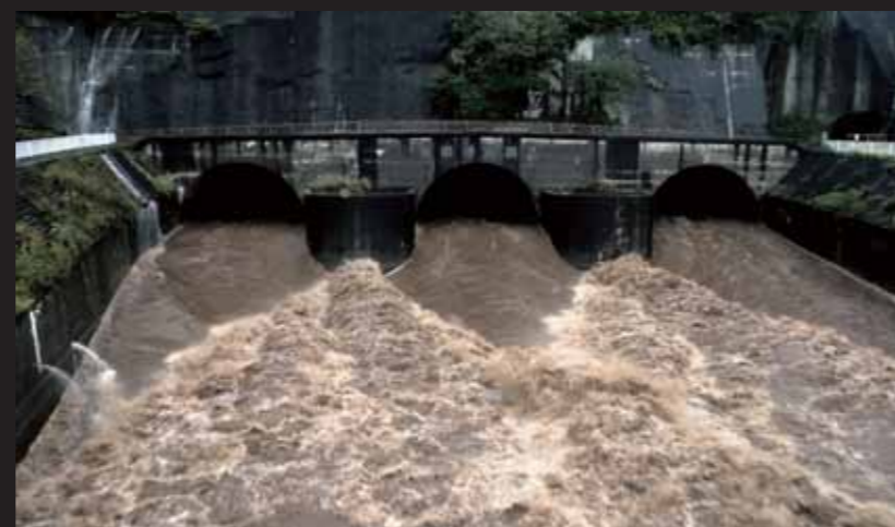
▲ 竣工後は水面下になって見えないが、計画変更時の検討で口野トンネルの下流にケーソンの床固めとバップルピアが付加。激流を減勢して床掘れを抑制している。（国土交通省）
