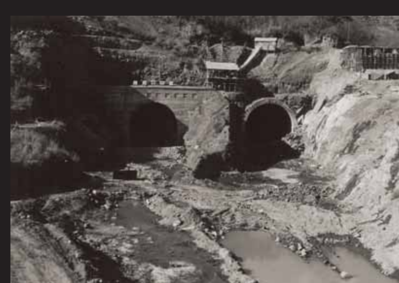
▲ 狩野川台風前の長岡トンネル建設状況（左）と狩野川台風後の同建設状況（右）。トンネルの底を深掘りするとともにトンネルの数も1本増設して、分流する水量を2倍にした。限られた地形条件の中でトンネルを近接配置させる必要があり、模型による実験などにより、トンネル断面形状、間隔が慎重に設計された。（国土交通省）
