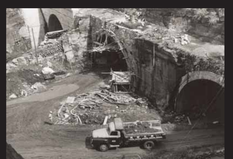
▲ 狩野川台風前の長岡トンネル建設状況（左）と狩野川台風後の同建設状況（右）。トンネルの底を深掘りするとともにトンネルの数も1本増設して、分流する水量を2倍にした。限られた地形条件の中でトンネルを近接配置させる必要があり、模型による実験などにより、トンネル断面形状、間隔が慎重に設計された。（国土交通省）
