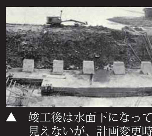
▲ 狩野川台風前の長岡トンネル建設状況（左）と狩野川台風後の同建設状況（右）。トンネルの底を深掘りするとともにトンネルの数も1本増設して、分流する水量を2倍にした。限られた地形条件の中でトンネルを近接配置させる必要があり、模型による実験などにより、トンネル断面形状、間隔が慎重に設計された。（国土交通省）
