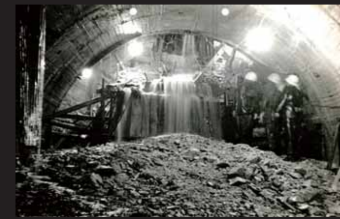
▲ 80mの破砕帯の掘進に7ヶ月。湧き水は最大毎秒660ℓ、水温4℃。（写真提供：関西電力株式会社）
