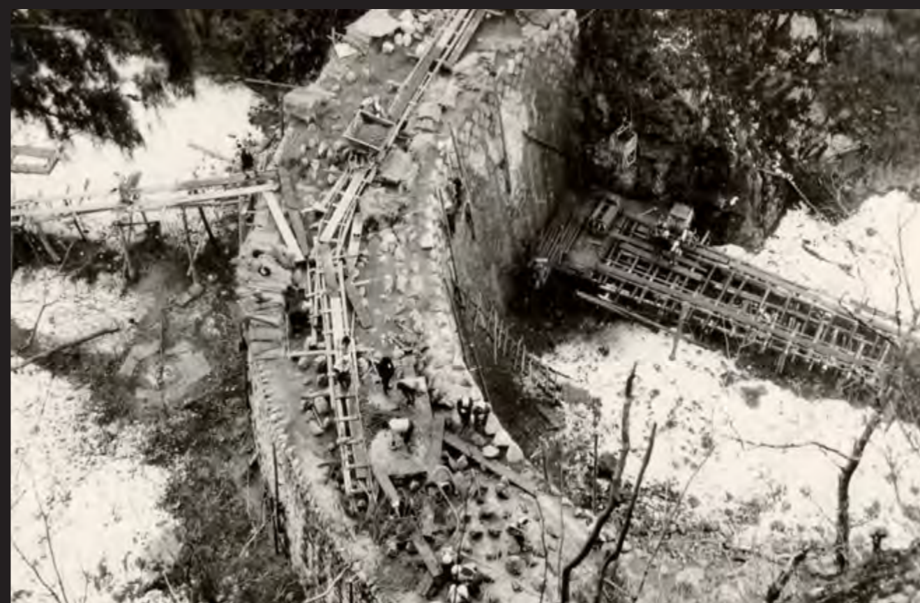
▲ 建設中の写真。石とコンクリートによる堰体の構造がわかる。
