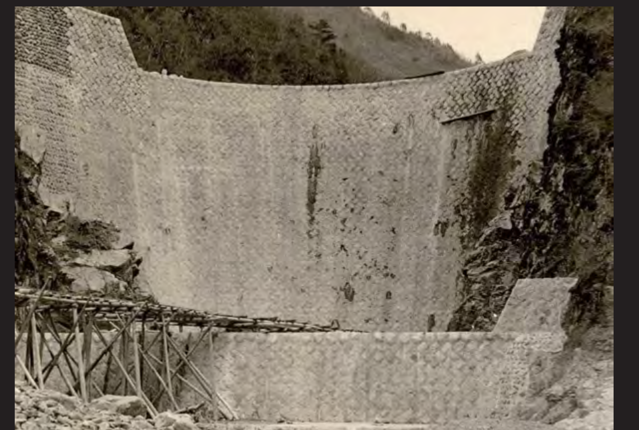
▲ 竣工直後の写真。下流側から見る。副ダムも本堤と同様に石積とコンクリートの構造体であったことが把握できるが、1967年に副ダムが3m嵩上げがされて現在の形になった。
