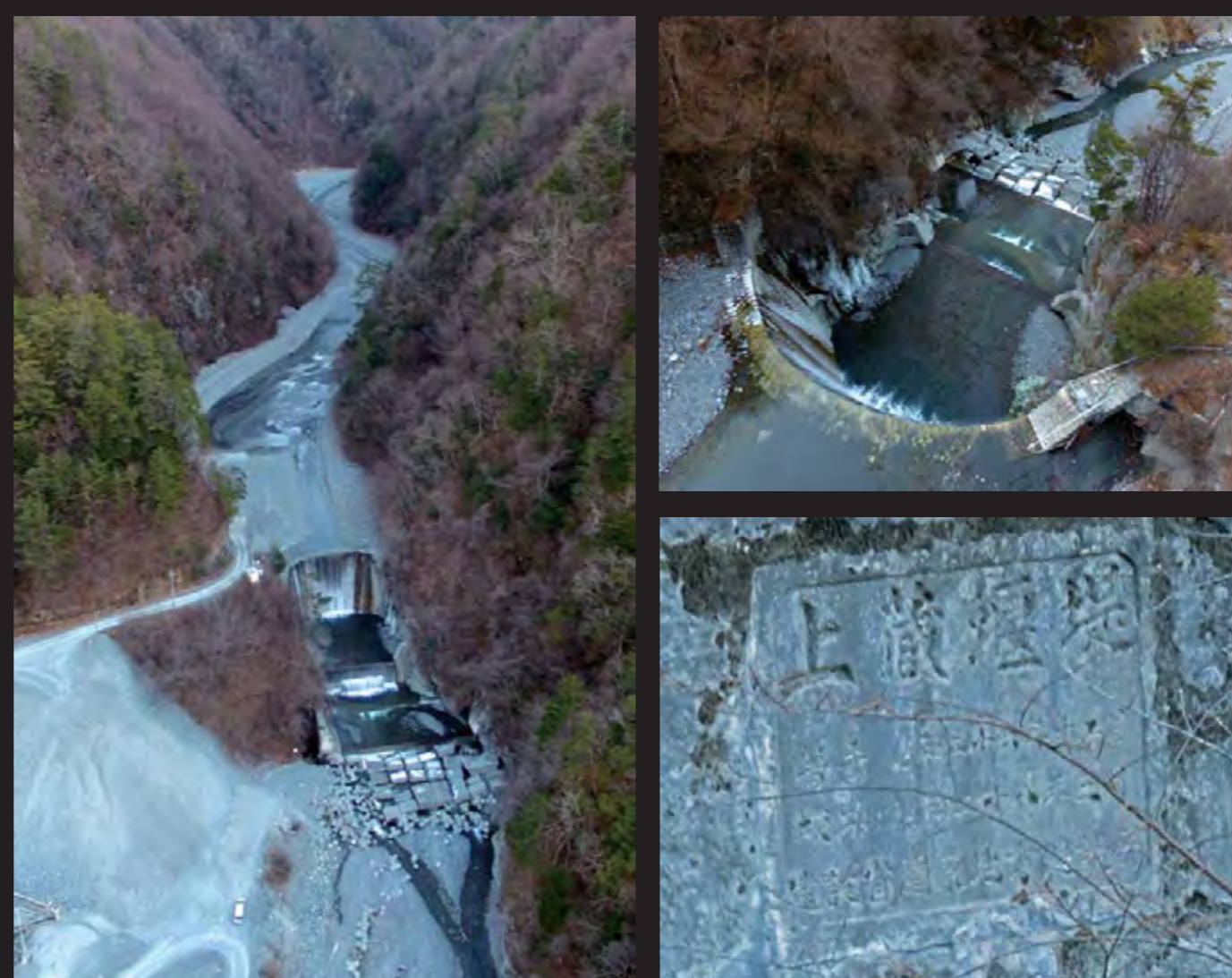
▲ 鳥瞰的にみる現在の上蔵砂防堰堤と小渋川の流れ（左写真は下流側から、右上写真は上流側から。大量の土砂が堆積していることがわかる。本堤の銘板（右下写真）には「上蔵堰堤」と書かれている。
