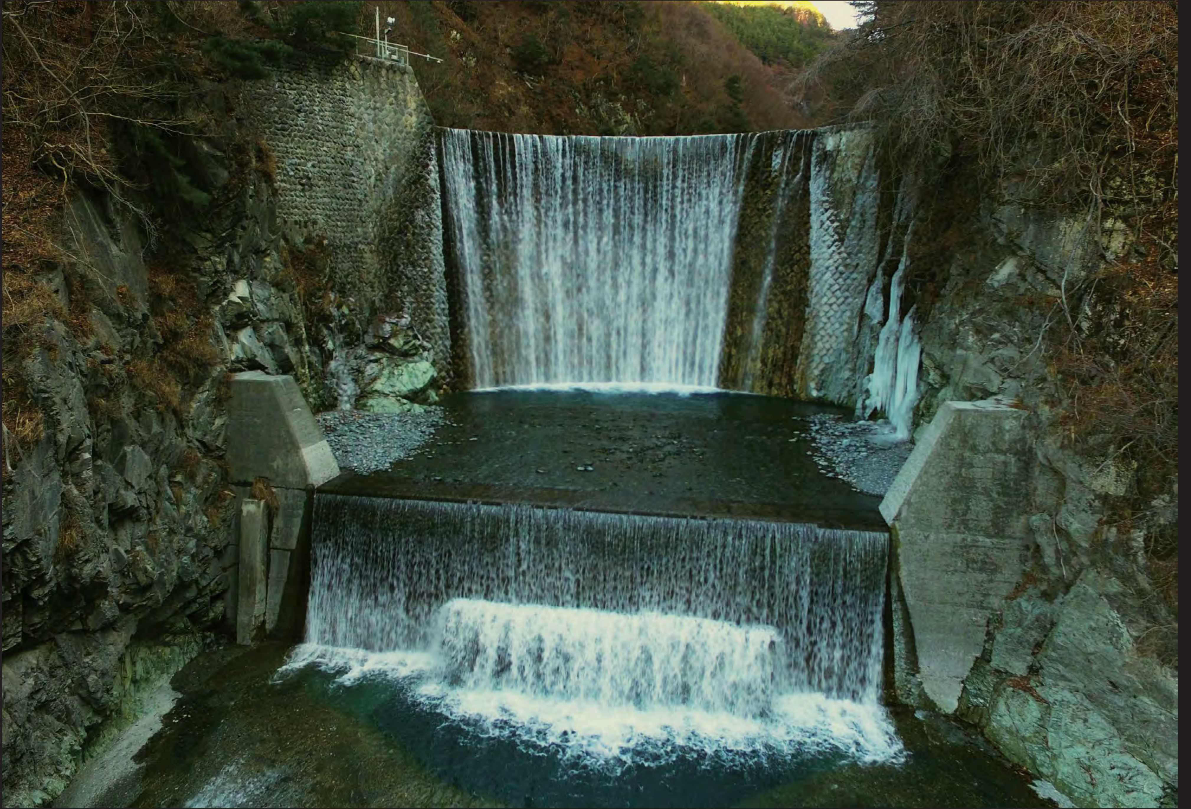
上蔵砂防堰堤の下流側からの全景。高さ 23m の威容を誇る。
