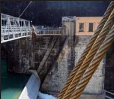
▲ 金属の綱が機械室で巻き上げられると、ピアに斜めに設けられたガイドに沿って、綱ドラムが回転しながら上がる。
