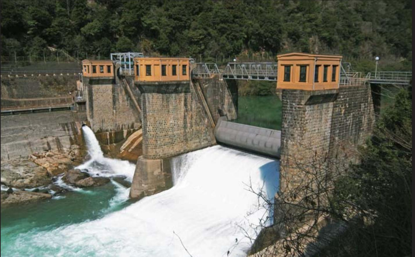
上麻生発電所取水堰堤を下流左岸側からみる。左側のドラムが少し掲げられて放水中。機械室の意匠も控えめながら美しくデザインされている。
