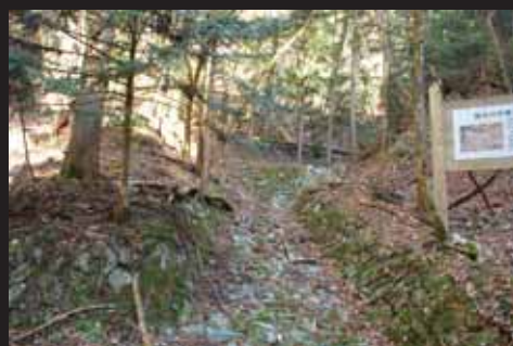
嫌谷には、砂防堰堤のみならず、流路工、帯工など他の砂防施設も遺されている。もしかすると山腹工も埋没しているかもしれない。
