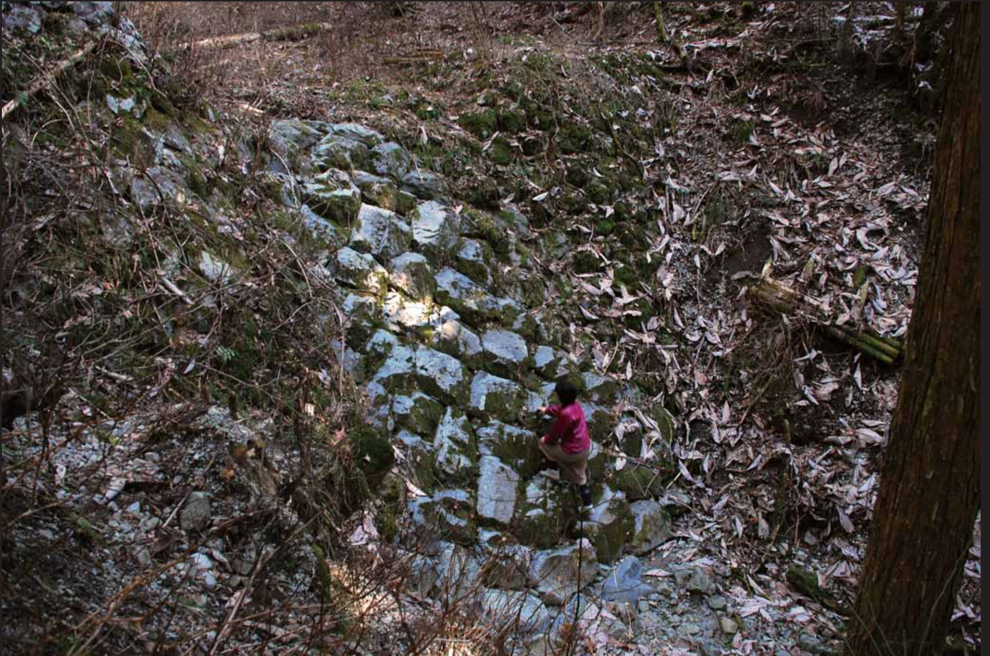
空石巨石積みの砂防堰堤（右下配置図の④）
