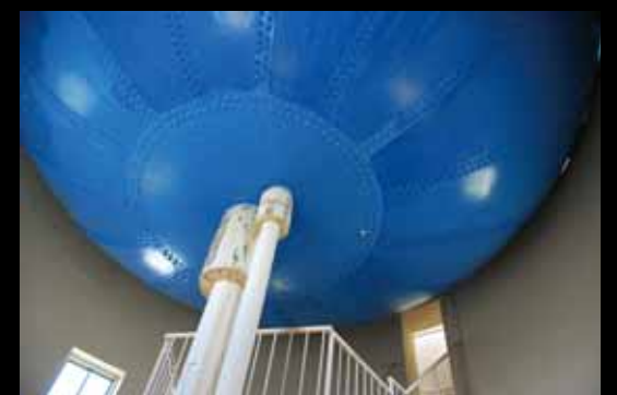
東山給水塔の貯水タンク 半径4.2mの鋼製オワン
