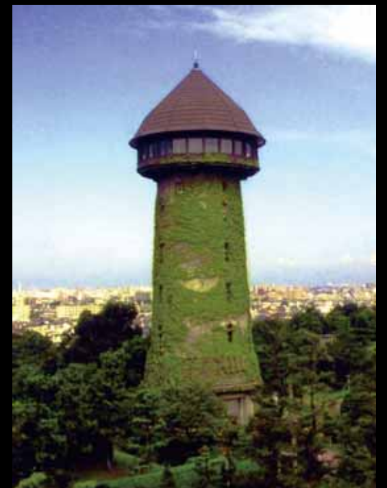
竣工時には「傘」はなかったが、昭和50年代の補修時に上屋が改装され、この姿になった。
