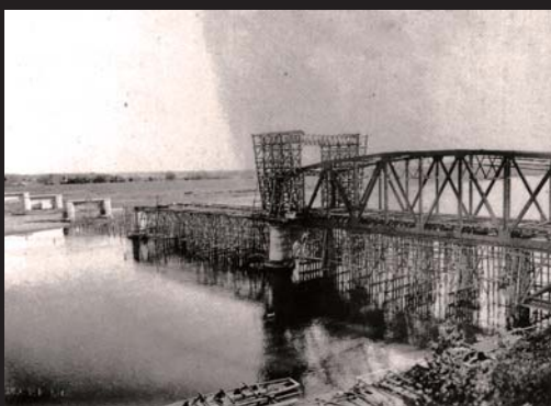
建設中の様子
