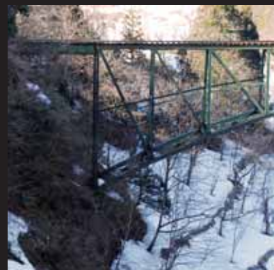
この形式は、Spandrel braced arch（構拱）と『小池橋梁工学』で紹介される。非バランスタイプとしては戦前最長のスパンだった。
