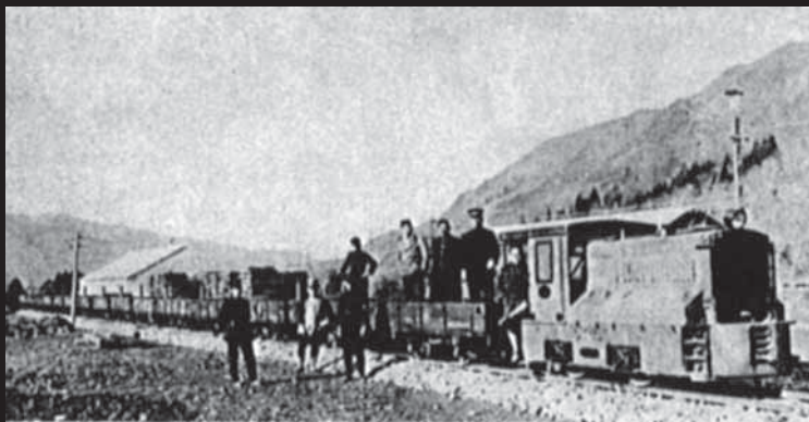
発電所建設用資材を輸送するトロッキ、千垣付近（『富山地方鉄道50年の歩み』1979）
