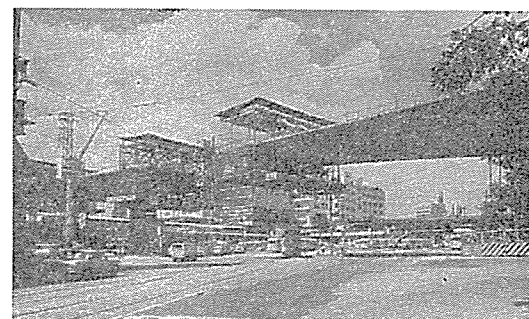
写真-5.64 首都高速道路 3 号線高架道路のカンチレバー架設
