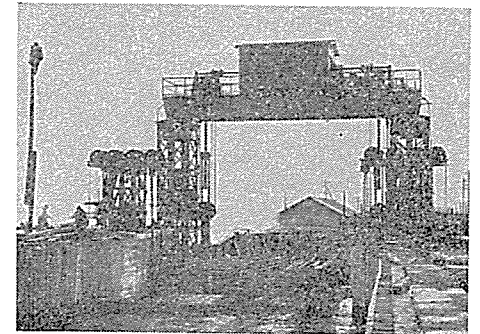
写真—5.9 船車連絡可動橋
