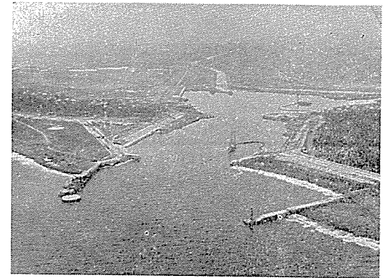
写真-3.19 掘込港湾(田子の港浦)
