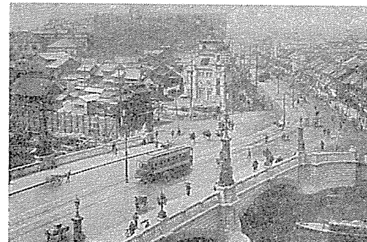
写真-2.9 大正初期の日本橋付近 （室町方向を望む、建設中のビルは三越呉服店）
