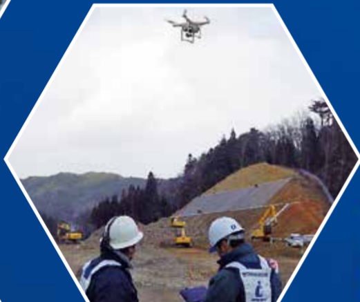
ドローンによる測量
