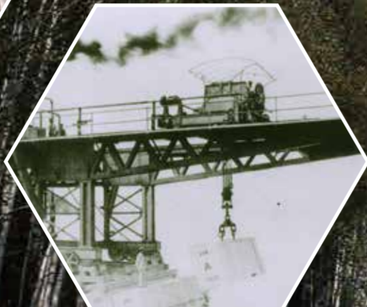
小樽港北防波堤の施工 (明治30年代)
