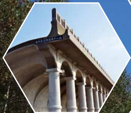
稚内港北防波堤ドーム
