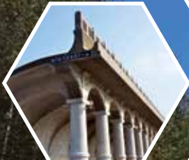
稚内港北防波堤ドーム
