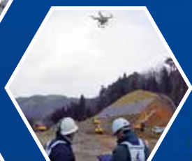
ドローンによる測量
