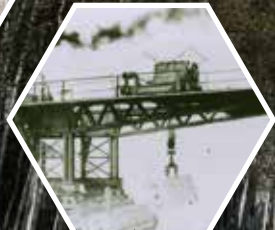
小樽港北防波堤の施工 (明治30年代)
