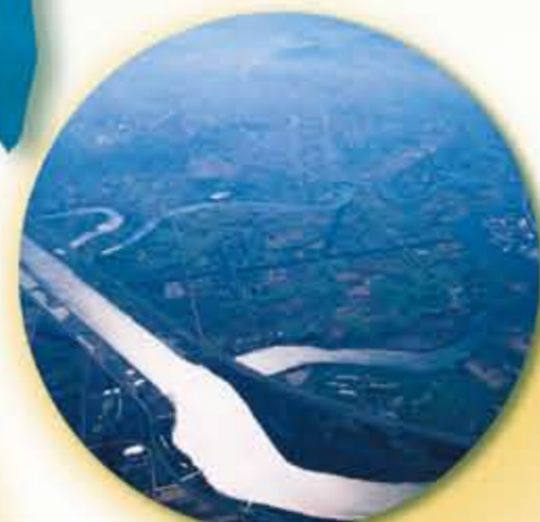
生振捷水路(石狩市)
