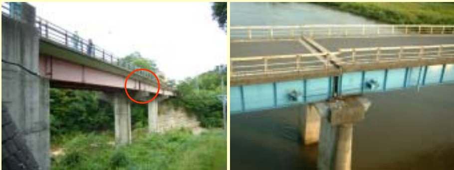
丹寿橋 (3径間単純鋼鈹桁橋) 2003年宮城北部地震で被災した小野橋
