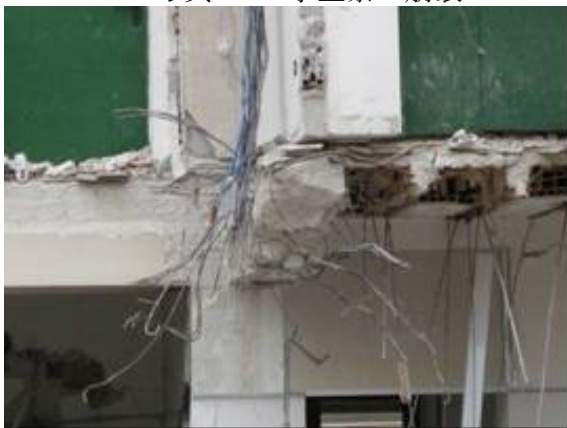
写真-71 2階梁とスラブ
