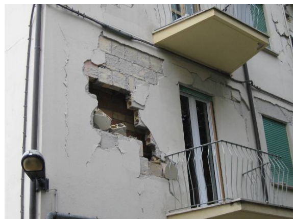
写真-68 空洞煉瓦壁を2重にして設置(5)
