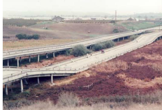
写真-138 ストラブスルー橋の被害 (1989年ロマプリータ地震)
