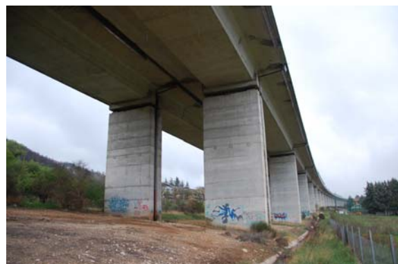
写真-150 A24 の高架橋
