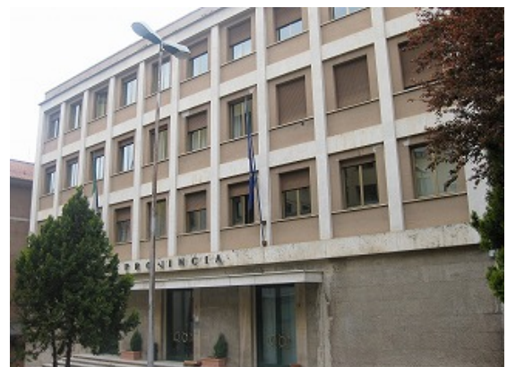
写真-54 行政関係の建物 損傷なし(11)
