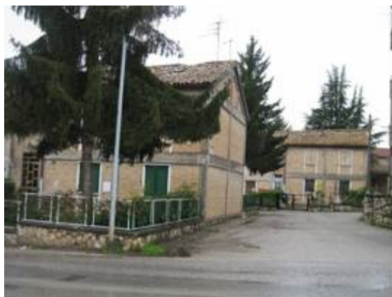
写真-96 低層RC造住宅
