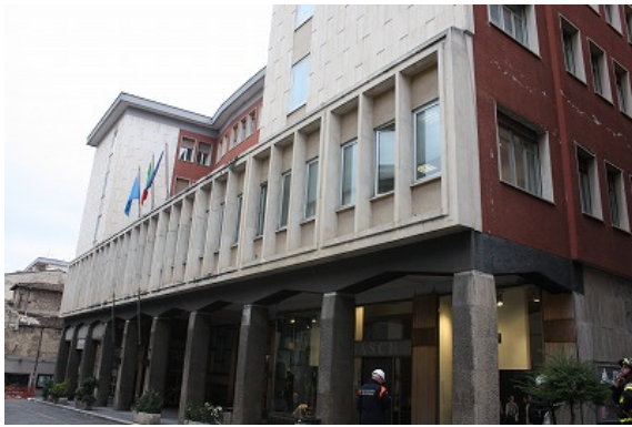
写真-39 1階部分がピロティ形式の建物(2)
