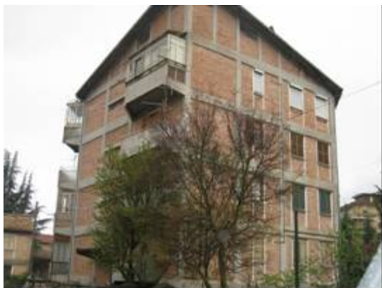
写真-99 4階建てRC造集合住宅
