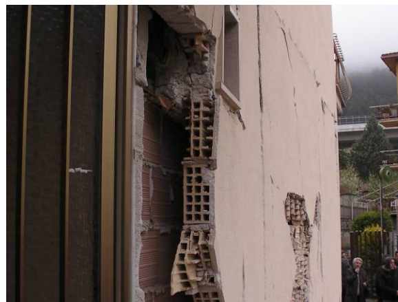
写真-110 壁の構造
