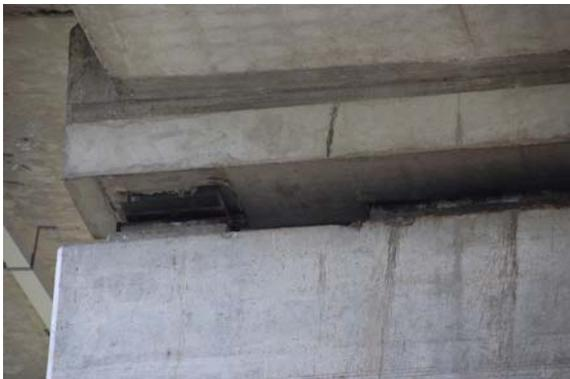
写真-155 桁中間部の支持状態
