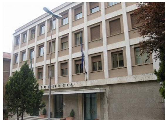
写真-54 行政関係の建物 損傷なし(11)
