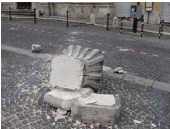
写真-21 教会の落下物
