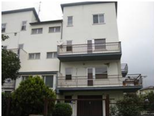
写真-91 4階建てRC住宅
