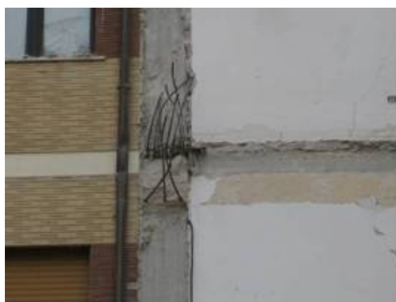
写真-72 4階連結梁主筋の露出と非連結の床
