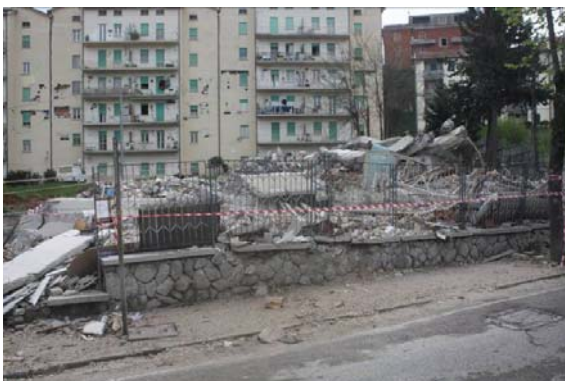
写真-55 倒壊した建物(1)
