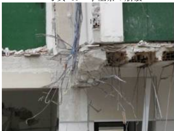
写真-71 2階梁とスラブ
