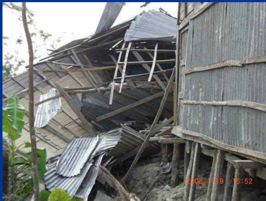
暴風で破壊された商店
