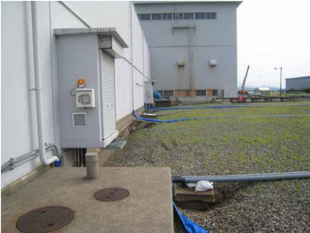
2号機熱交建屋海側
