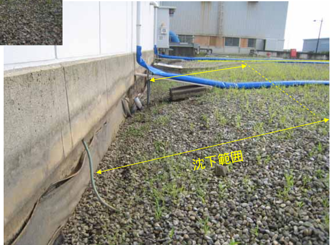
2号機熱交建屋海側
