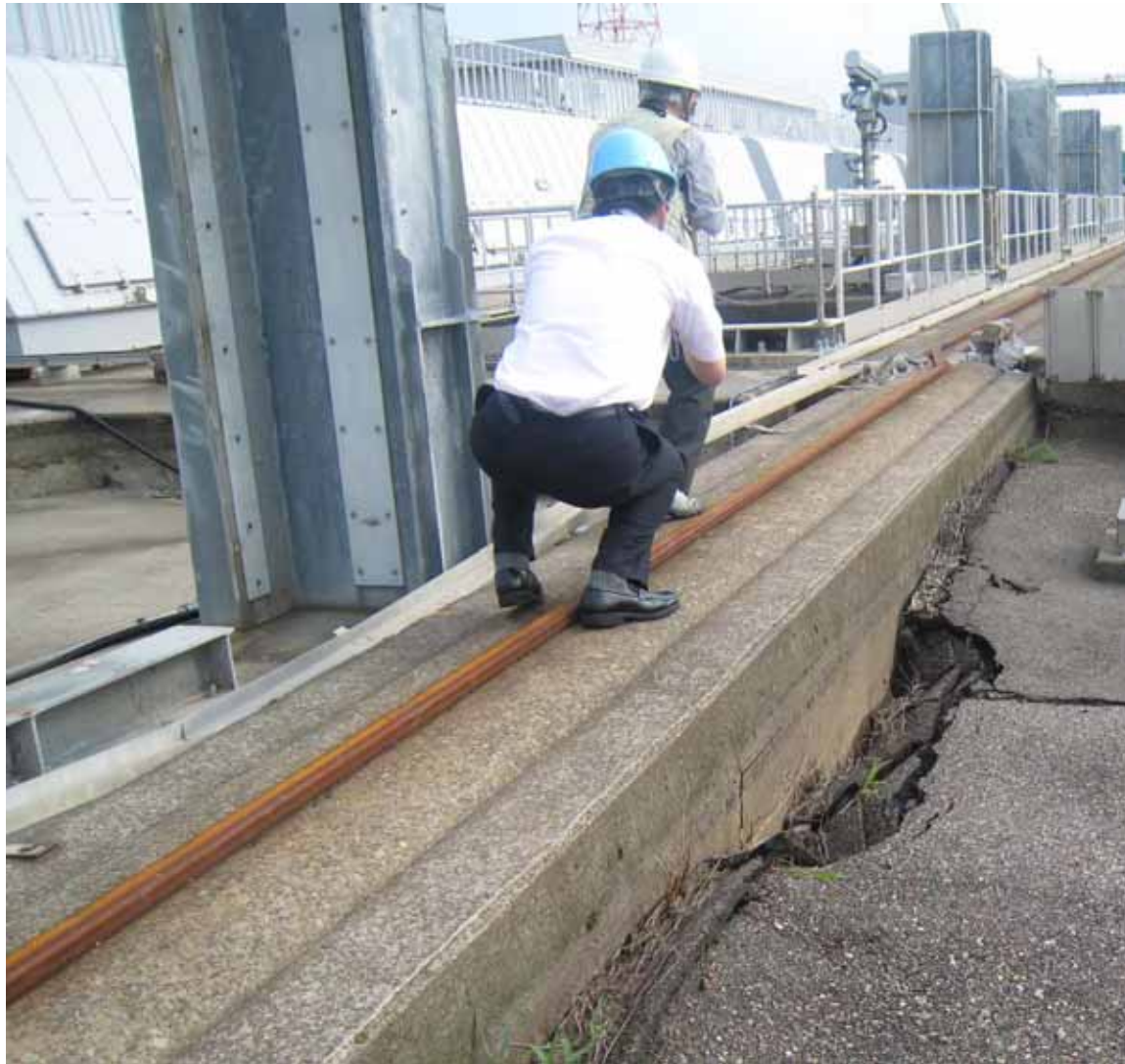
2号機取水ピット付近護岸
