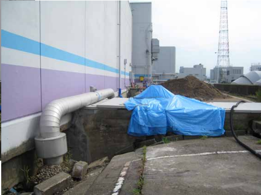
2号機タービン建屋海側
