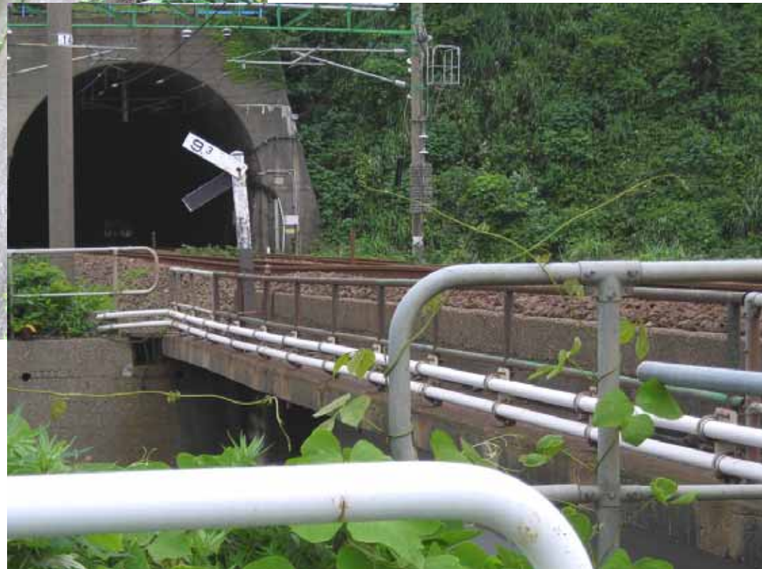
橋梁部と盛土
