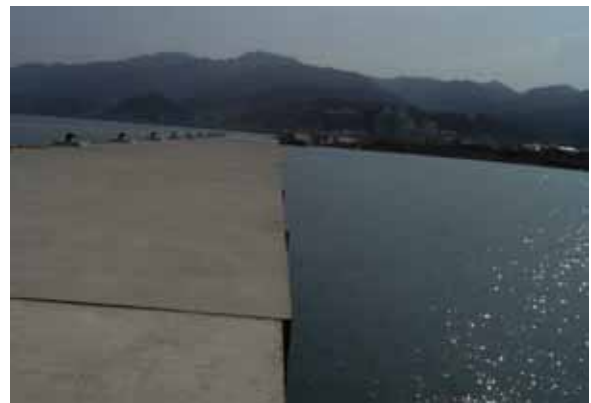
写真1b 輪島港-7.5m ケーソン式岸壁 (目地部拡大)
