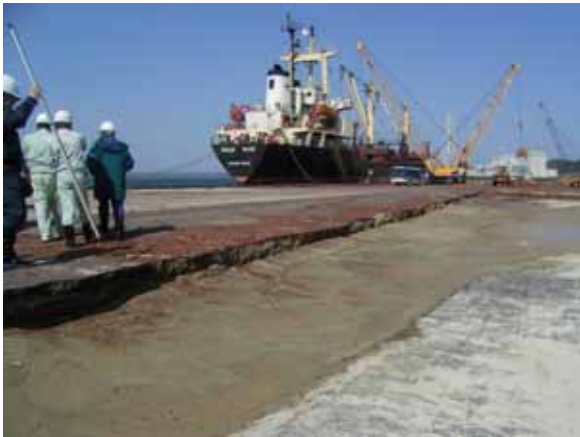
写真3 七尾港-10m 矢板式岸壁 (手前が1号、船舶接岸部分が2号)
