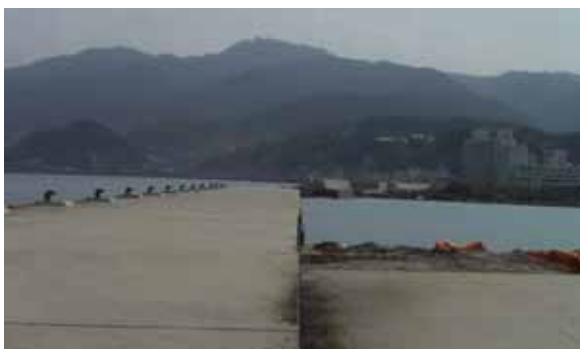
写真1a 輪島港-7.5m ケーソン式岸壁
