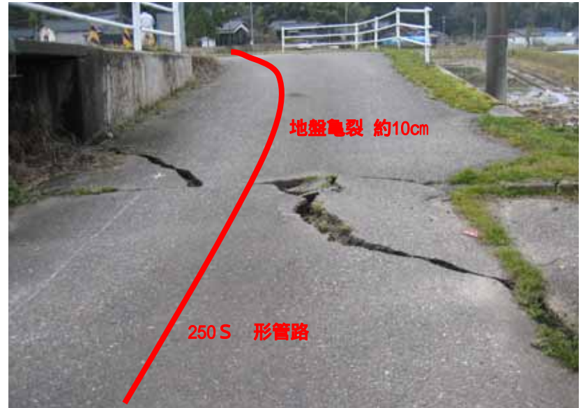
250 DIPのS 形の被害なし
