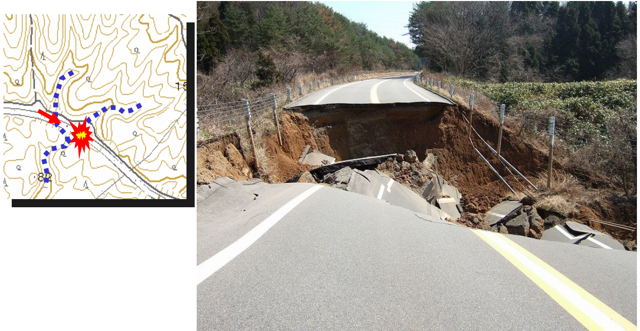
図 4. 豊川橋北 (N37°8'19", E136°50'33" : 図 1 中第 3 地点)
