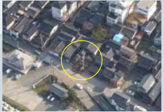
旧輪島市街地 河井町の民家の倒壊
