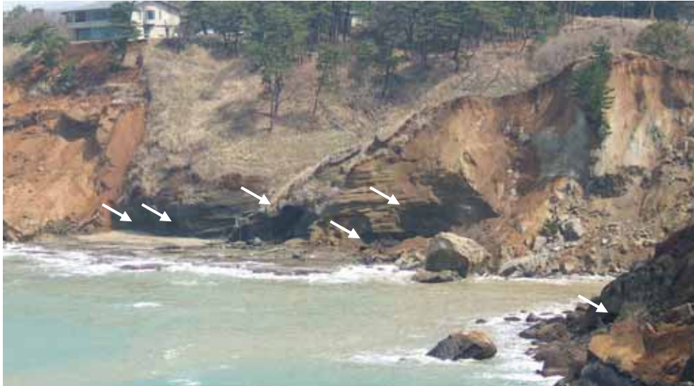
図 4 石灰質砂岩の堆積構造、石灰質が溶け出し、波蝕も加わって根元が空洞化（白矢印）していたことが崩壊の原因と推定される（関野鼻、N37 度 12 分 50 秒，E136 度 41 分 18 秒）。
