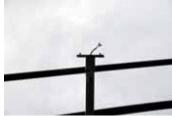
照明塔の照明が落下(2ヶ所)
