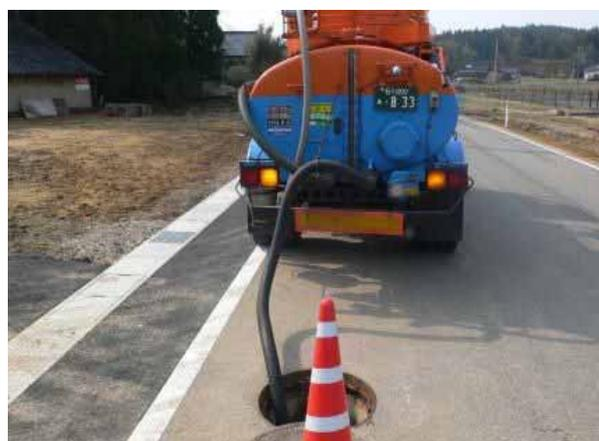
写真 9.2.3-2 バキュームによるマンホールの汲み上げ（志賀町）
