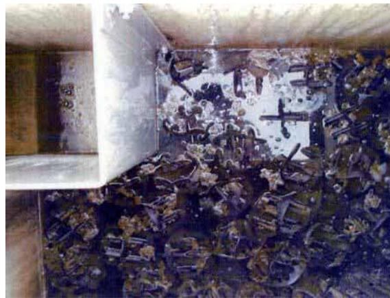
写真 9.2.2-3 接触材の浮上（石川県撮影）
