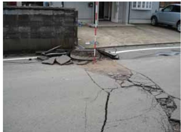
写真 9.2.2-5 下水道管路施設の被災状況
