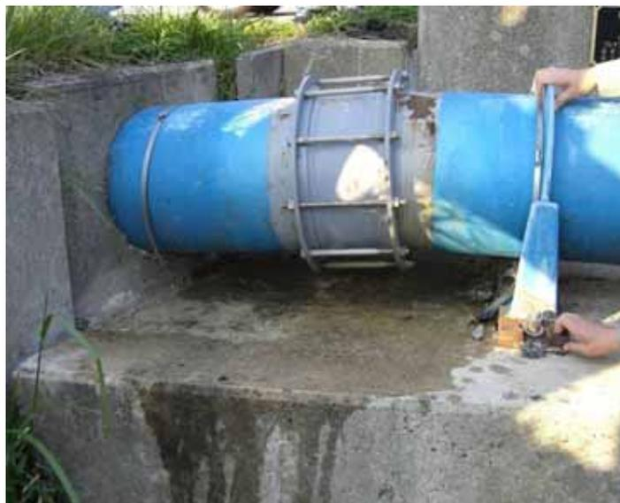
写真 9.1.3-1 水管橋伸縮管の損傷状況<sup>1)</sup>
