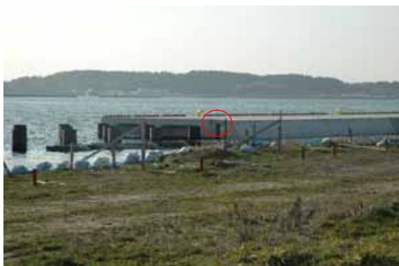
写真 7.3-3 矢田新町地区の七尾港岸壁 (-7.5m) 改修工事現場
