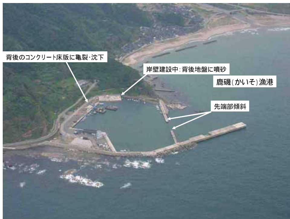
写真 7.4-1 鹿磯漁港の被災状況 5) に加筆
