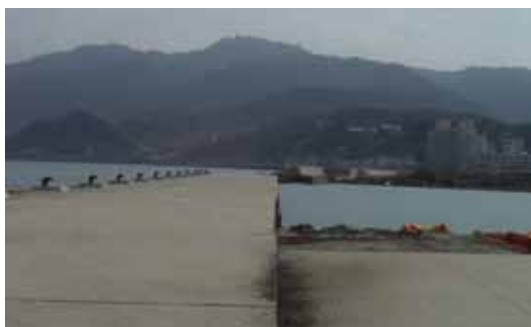
写真 7.1-1 輪島港-7.5m ケーソン式岸壁
