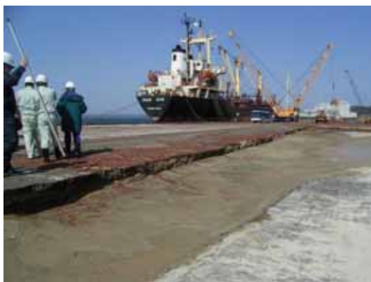
写真 7.3-5 七尾港-10m 矢板式岸壁 (手前が1号, 船舶接岸部分が2号)
