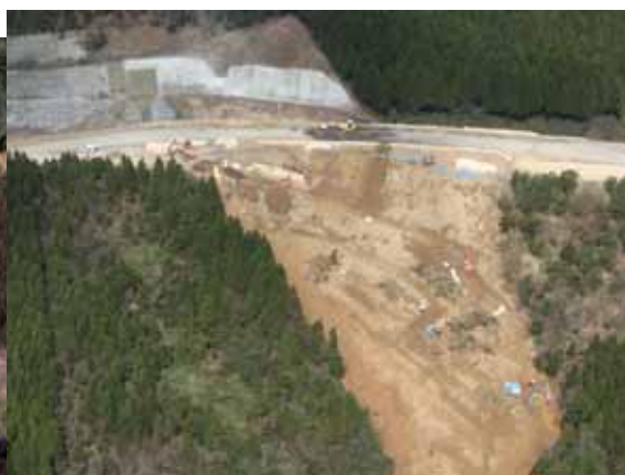
写真 5.9.1-2 NO.縦 - 38 応急復旧後写真
