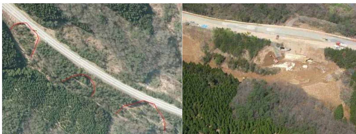
写真 5.11.1-1 NO.縦 - 39 被災後写真
