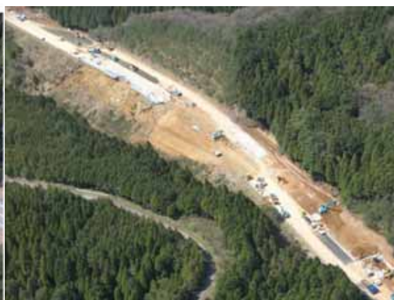
写真 5.7.1-2 NO.縦-26 応急復旧後写真
