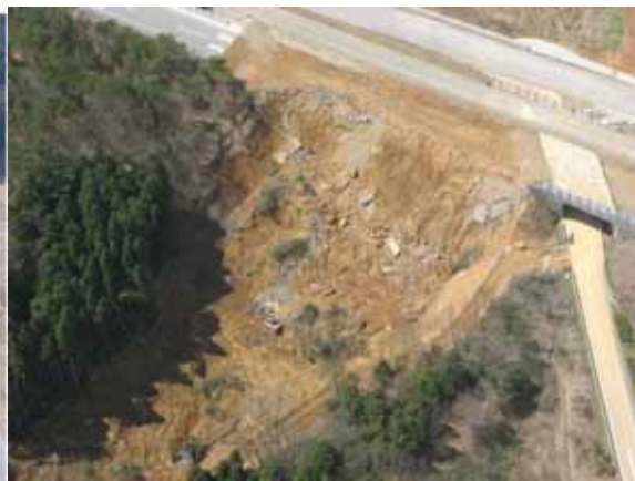
写真 5.8.1-2 NO.縦-32 応急復旧後写真
