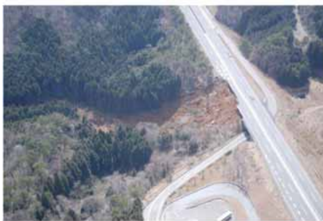
写真 5.8.1-1 NO.縦-32 被災後写真
