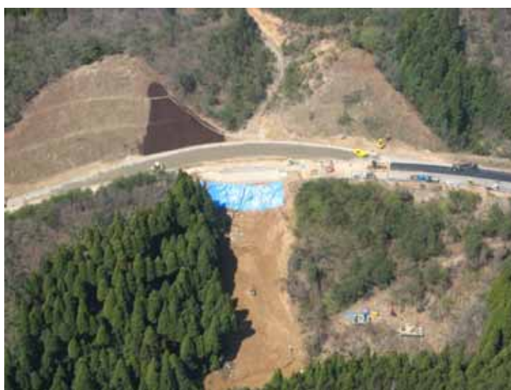
写真 5.6.1-2 NO.縦 - 21 応急復旧後写真
