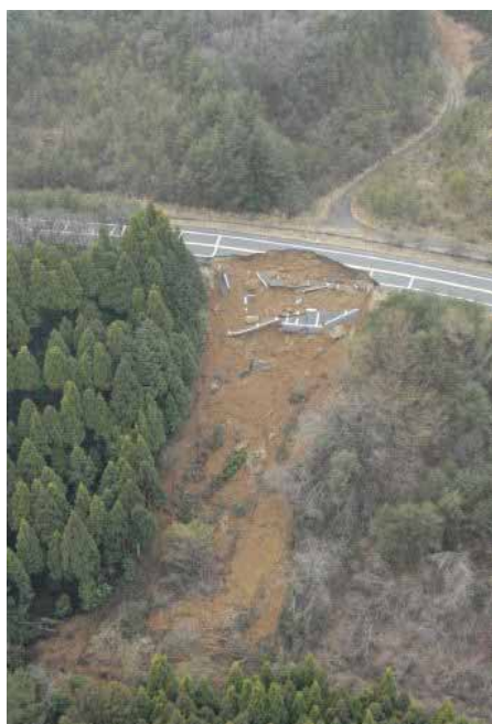
写真 5.6.1-1 NO.縦 - 21 被災後写真
