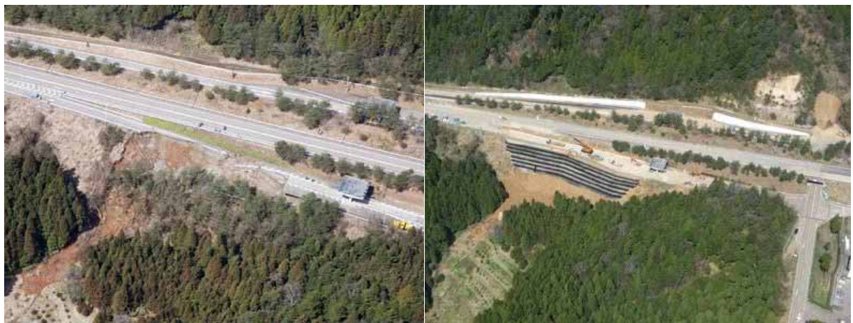
写真 5.4.1-1 NO.縦 - 10 被災後写真
