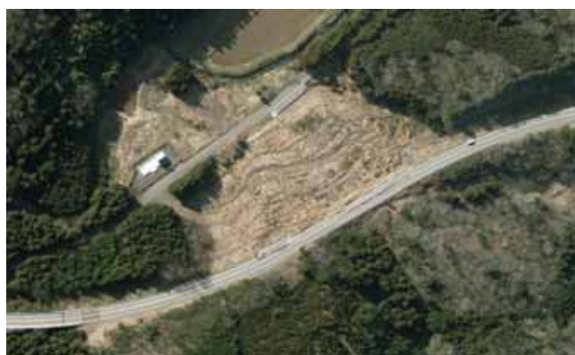
写真 5.3.1-1 NO.縦 - 9 被災後写真
