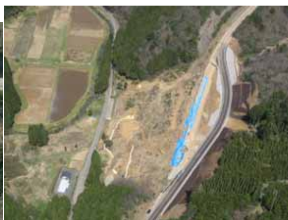
写真 5.3.1-2 NO.縦 - 9 応急復旧後写真
