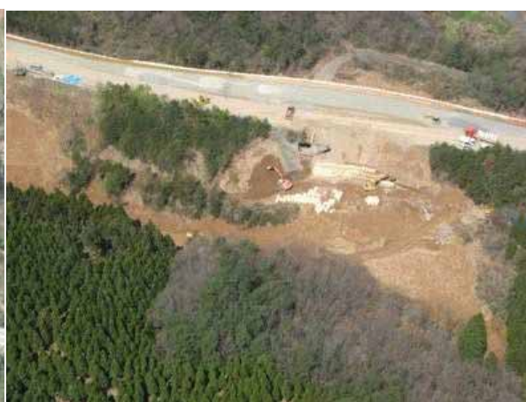
写真 5.12.1-2 NO.縦－39 応急復旧後写真
