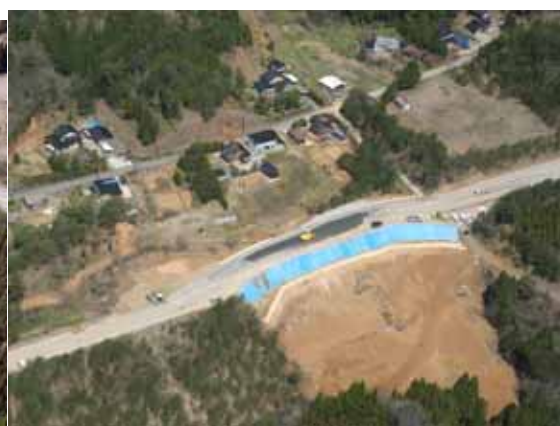
写真 5.13.1-2 NO.縦－41 応急復旧後写真
