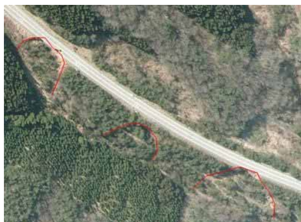
写真 5.12.1-1 NO.縦－39 被災後写真
