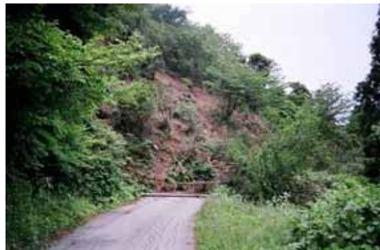
写真 4.2-4 地すべり崩土が崩落（S-38）
