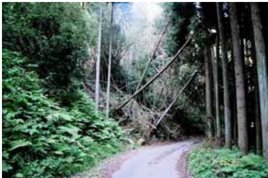
写真 4.2-1 市道沿いの表層崩壊(地すべり地形の滑落崖,S-33)
