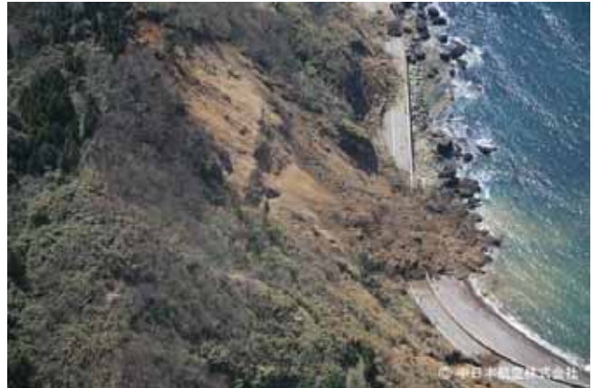
写真 4.1.3-2 最大規模の崩壊(S-13 地点)と上は S-14 地点(中日本航空株式会社撮影)
