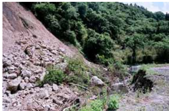
写真 4.1.7-4 崩壊地直下の河道閉塞
