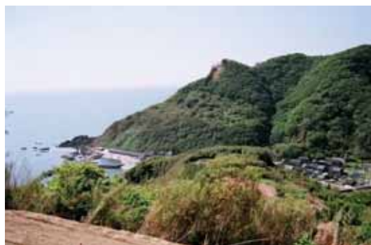
写真 4.1.3-16 尾根直下の表層崩壊 (S-32)
