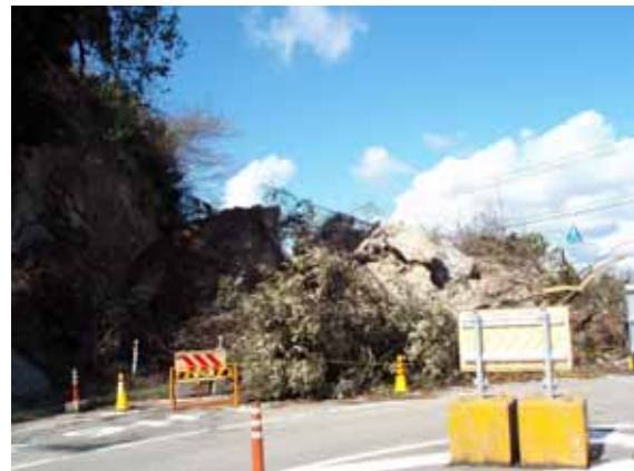
写真 4.1.1-2 横から見た尾根状部の転倒崩壊
