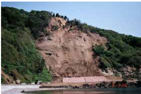
写真 4.1.3-8 市道沿いの深層崩壊（S-13）
