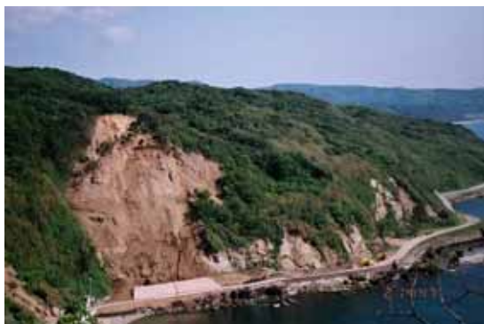
写真 4.1.3-3 市道沿いの斜面崩壊
