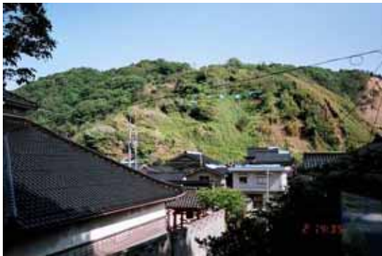
写真 4.1.3-12 背後斜面（左岸側 S-30）の状況
