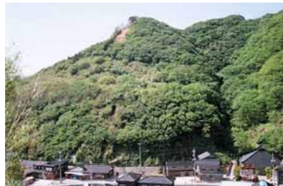
写真 4.1.3-13 背後斜面（右岸側 S-31）の状況
