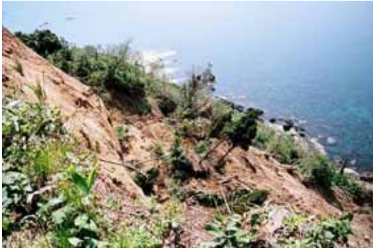
写真 4.1.3-10 深層崩壊の上部 崩土が残留
