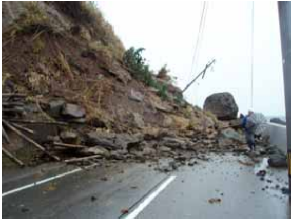
写真 4.1.3-1 表層崩壊と落石(S-14 地点)
