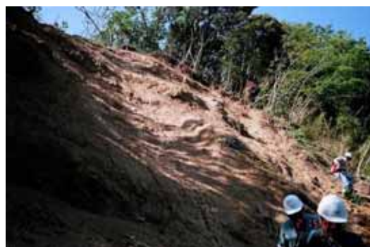
写真 4.1.3-17 表層崩壊の状況
