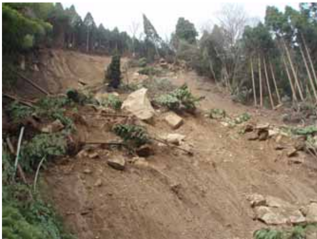
写真 4.1.6-1 山頂部、遷急線付近からの崩壊状況
