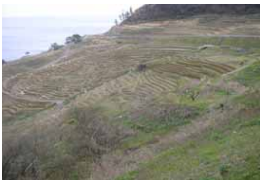
写真 4.4-1 輪島市白米町千枚田は全く地すべり被害がなかった。
