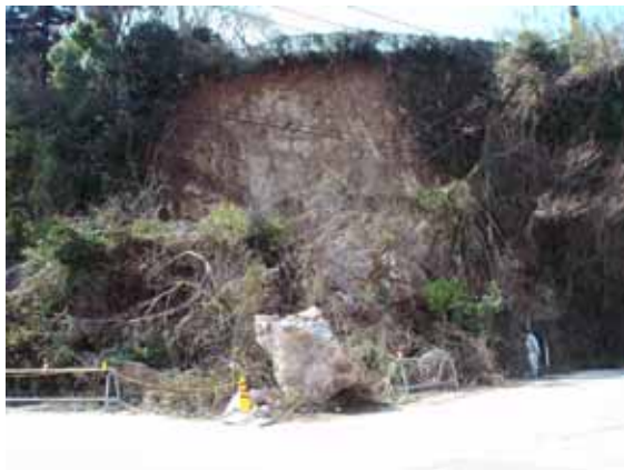
写真 4.1.1-1 正面から見た尾根状部の崩壊
