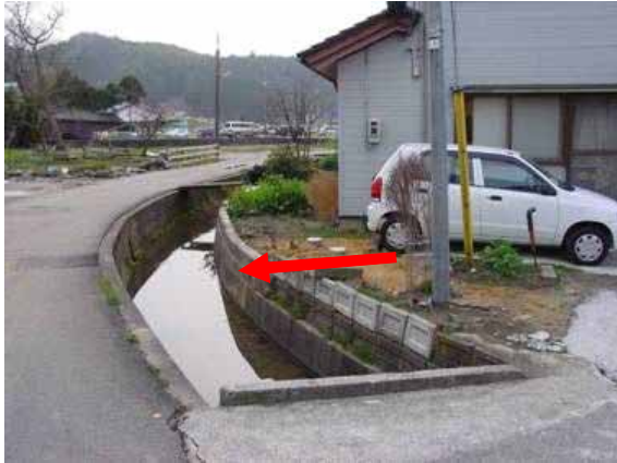
写真 3.5-1 地盤の側方流動
