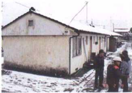
補強コンクリートブロック造市営住宅の建物（正院町正院、B-1, A棟）
