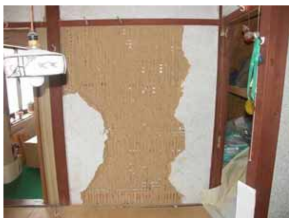
写真 11-9 建物内部例（輪島市門前町清水）
