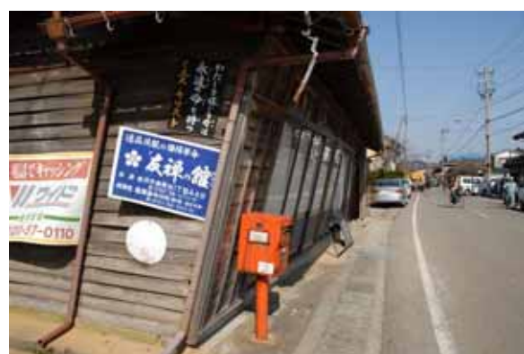
写真 11-11 建物被害例（輪島市門前町道下）
