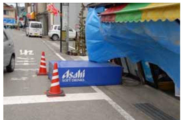
写真 11-18 建物被害例(穴水町大町)
