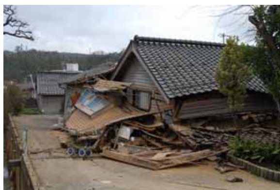
写真 11-10 建物倒壊例（輪島市門前町道下）
