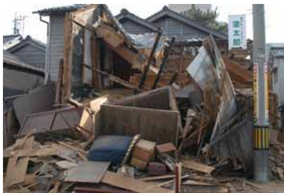
写真 11-1 建物倒壊例（輪島市河井町）
