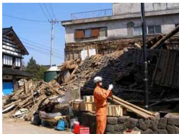
写真 11-5 建物倒壊例（輪島市門前町走出）
