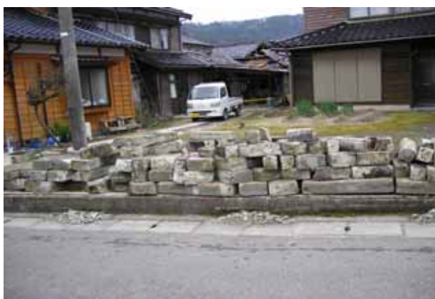
写真10.2-8 ブロック塀の倒壊
