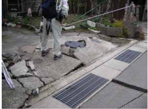
写真10.3.1-1 液状化による合併浄化層の隆起
