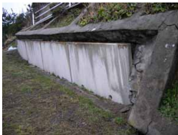
写真10.5.1-3 フリーフレーム枠のずれ
