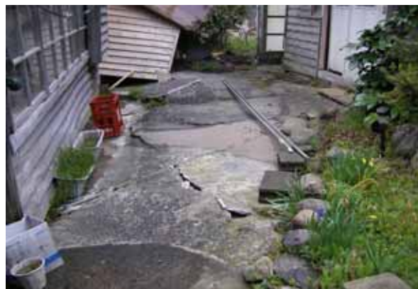
写真 10.3.1-5 地盤の隆起によるモルタル部の亀裂盤の隆起
