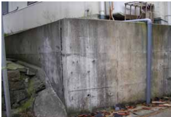
写真10.2-1 現場打ちL型擁壁：コーナー部 (コーナー部に目地を施工しているため)
