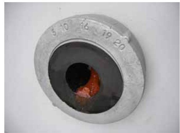
写真10.5.1-5 アンカー工の頭部の抜け出し
