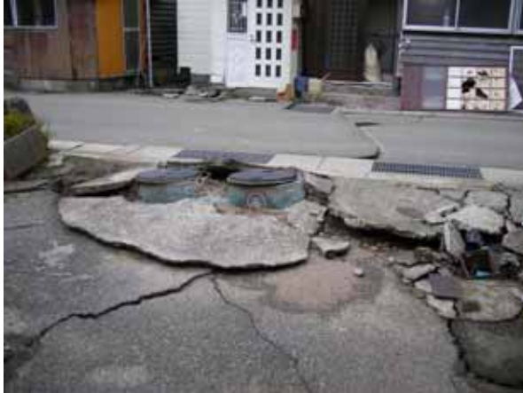
写真10.3.1-1 液状化による合併浄化層の隆起
