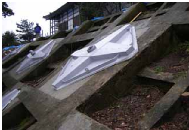
写真10.5.1-5 アンカー工の頭部の抜け出し
