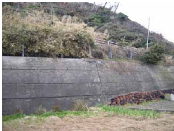
写真10.5.1-2 擁壁部の傾斜・クラック
