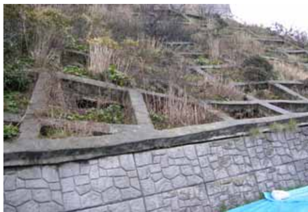
写真10.5.1-3 フリーフレーム枠のずれ
