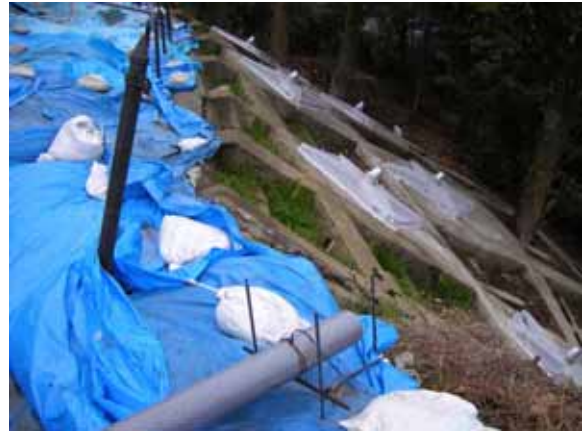
写真10.5.1-4 門前町菅原神社：宅地斜面被害の地すべり
