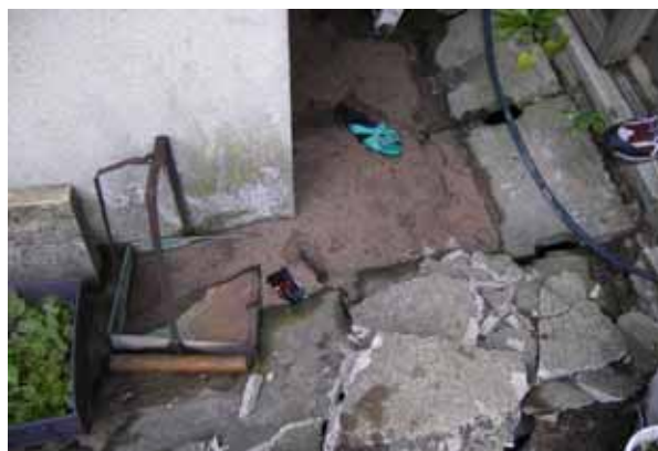
写真10.3.1-6 液状化による宅地地盤の隆起
