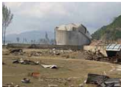
(d) Washed Away Tank
