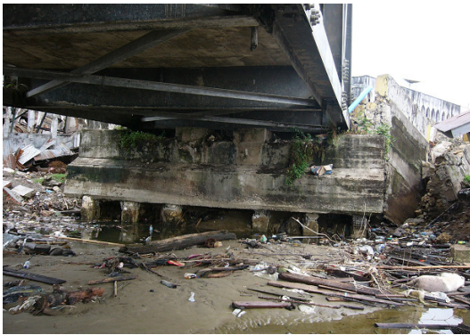
写真-15 橋台の杭が露出し杭頭が損傷
