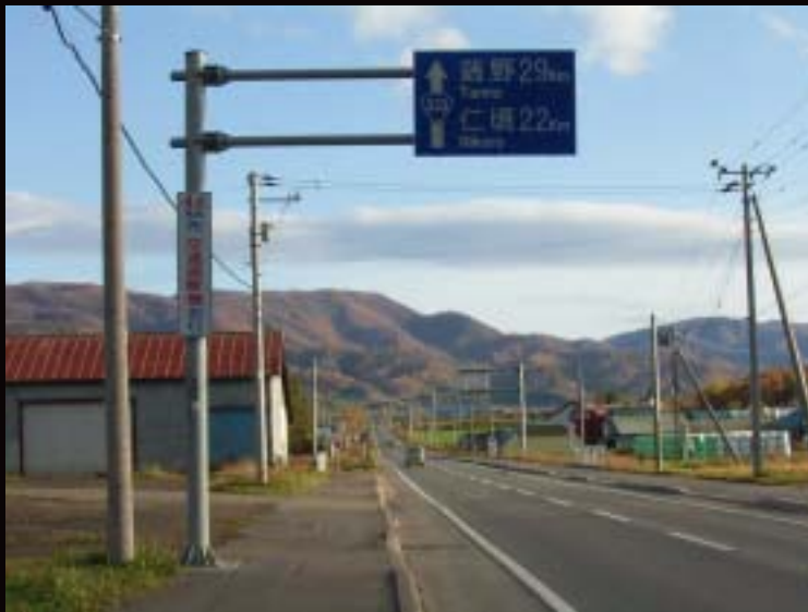
倒壊前の標識(実物)
