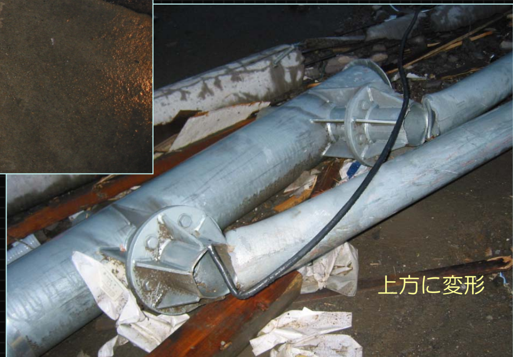
■ 横梁取り付け部
