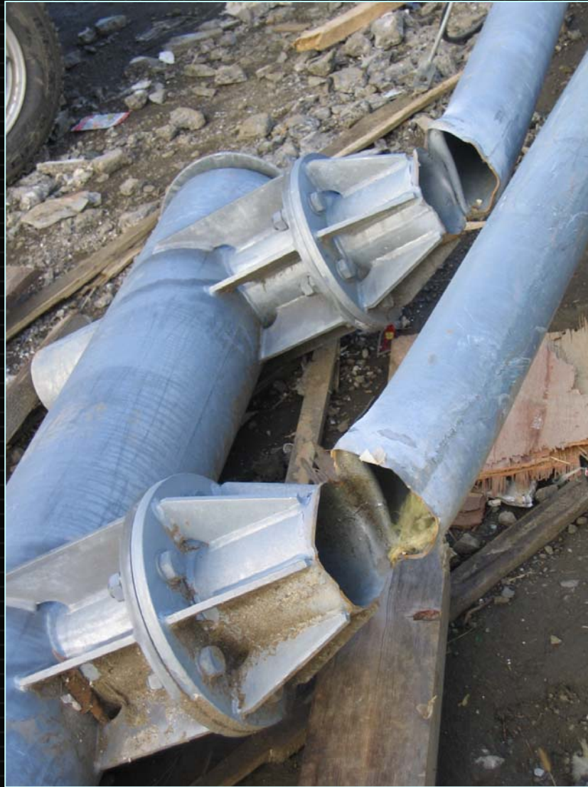
■ 横梁取り付け部
