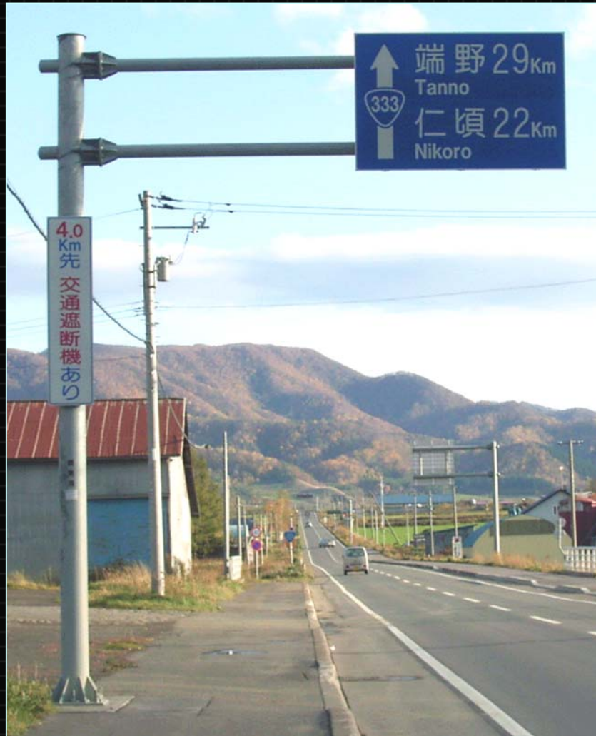
被災前に撮影された道路標識柱
