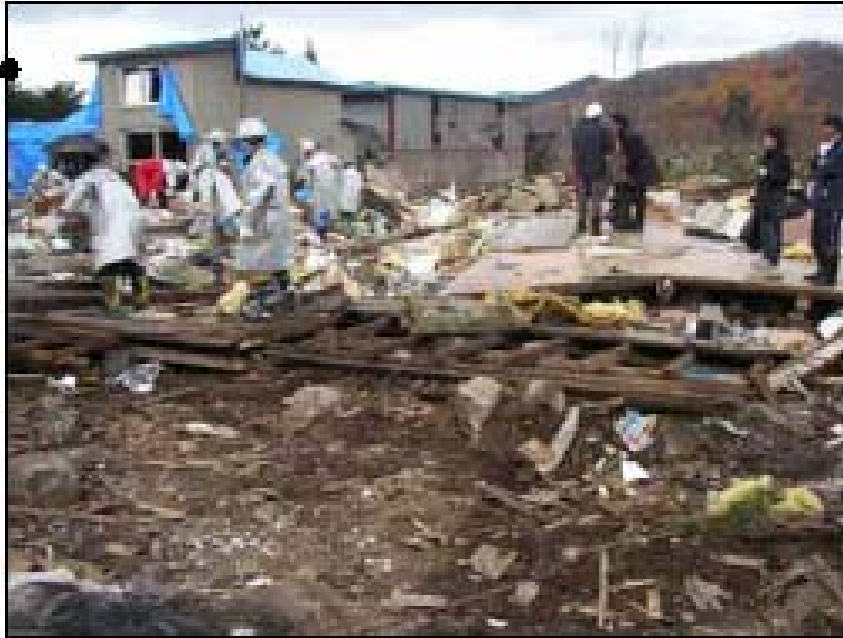
写真1. 倒壊した住家跡
