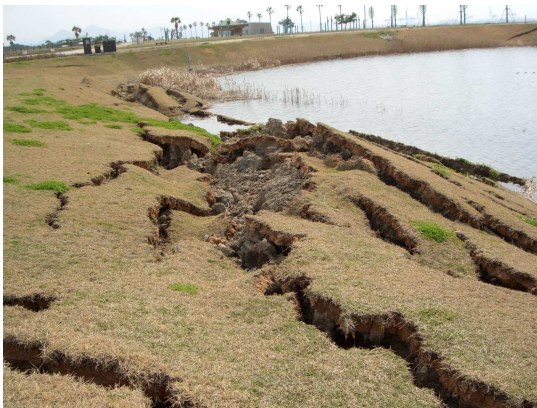
写真 4.20 海の中道海浜公園（光と風の広場）内での地盤の流動
