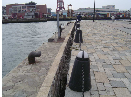
写真 4.22 中央埠頭イベントバースでの地盤の流動
