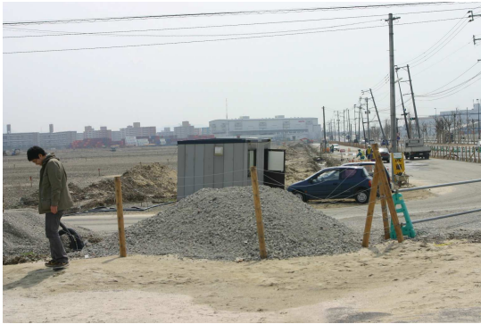
写真 4.7 アイランドシティでの噴砂跡
