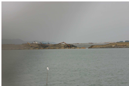
写真 4.16 アイランドシティ B4 仮護岸の崩壊
