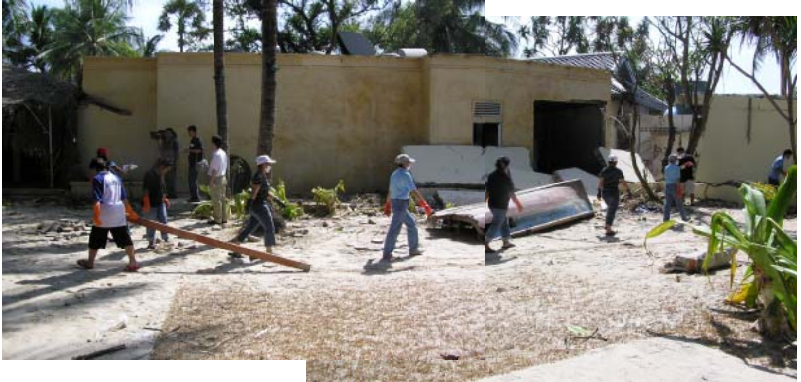
写真-1 壁が破壊された煉瓦造の家屋(Patong ビーチ, 海側から望む)
