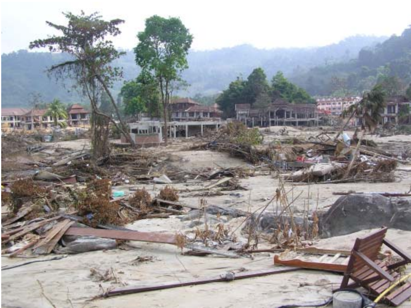
写真-2 廃墟と化したホテル群 (Khao Lak, 海側から望む)
