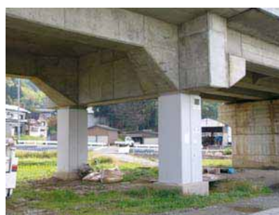
写真 5 鋼板による補強状況
