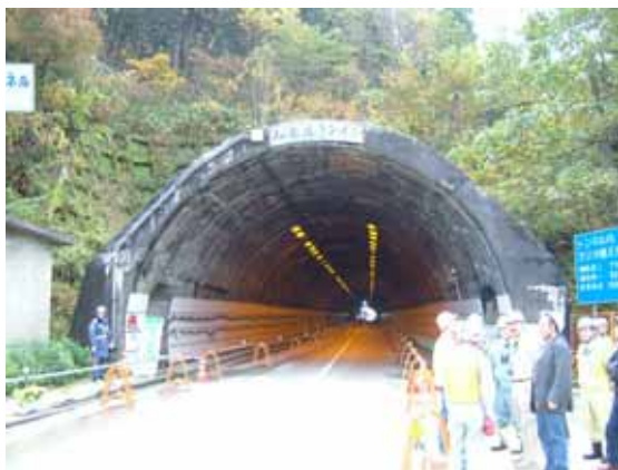
写真 1 トンネル概要(東京側坑口：無被害)
