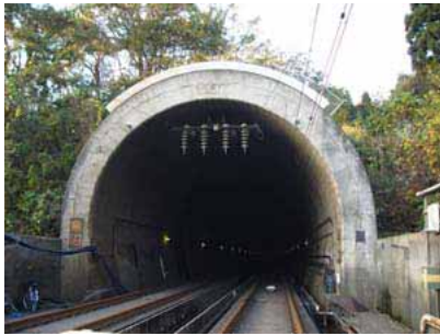
写真1 トンネル坑口
