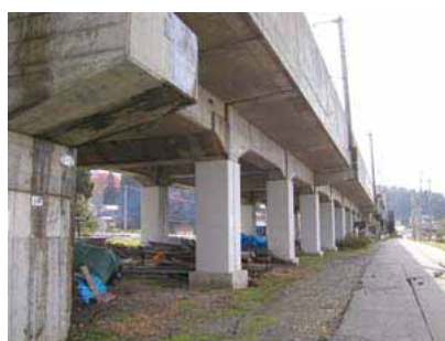
写真 4 耐震補強された橋脚
