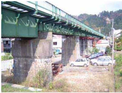
写真 1 高架橋部全景
