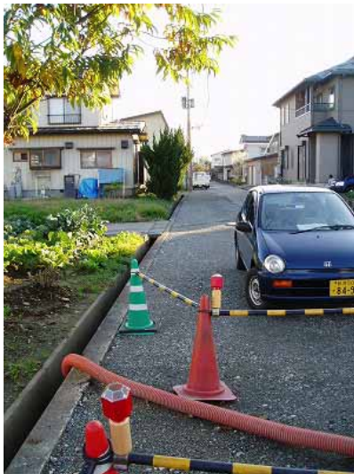
写真 7 図 6 よりもたらされた下水。 右手にあるマンホール(写真にない)に 排出される。
