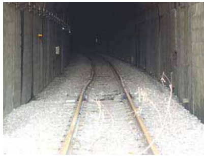
写真 2 レールの状況
