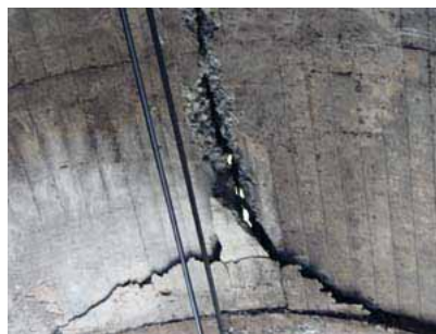
写真 5 坑口クラウン部
