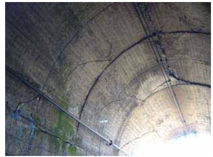
写真 3 坑口付近の状況
