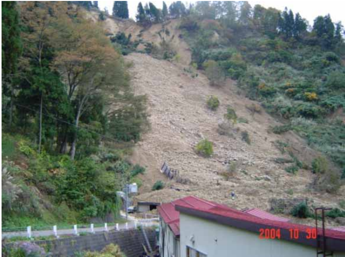
写真-2 羽黒トンネル西側坑口南寄り上部の斜面崩壊 （目測：幅 60m、斜面長さ 200m、傾斜 30 度、すべり面深さ 15m、崩壊土量 18 万 \text{m}^3 ）
