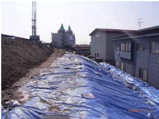
写真 4 堤内地側での堤防の応急復旧状況
