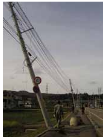
写真4 電柱の傾斜
