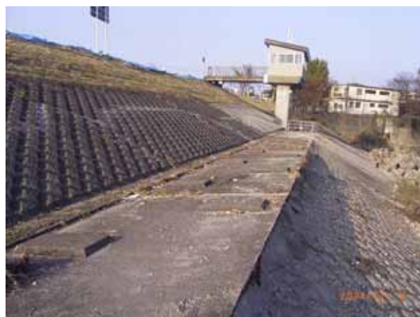
写真 2 補修済みのコンクリート護岸
