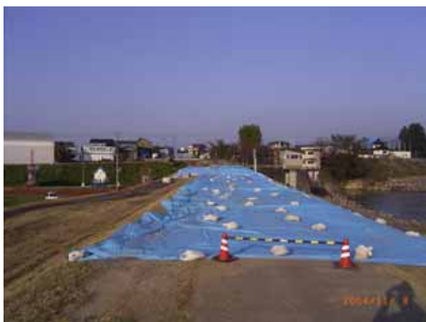
写真 1 応急復旧済みの土堤
