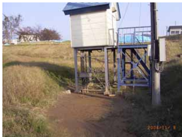
写真 3 堤内地側で見られた大規模な噴砂
