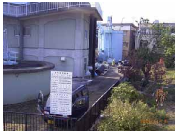
写真 4 浄水場における復旧工事
