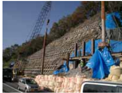
写真 2 のり面の補強工事の様子
