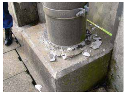
写真 3 電柱基部の緩衝装置
