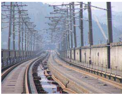
写真 1 レールの損傷状況
