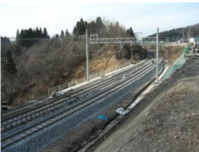
12 月 19 日時点での復旧状況
