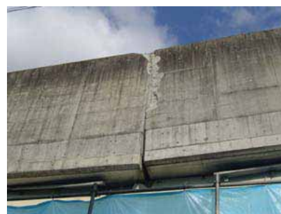
写真 3 上部工の状況
