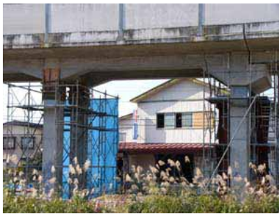
写真 1 被災・補修状況
