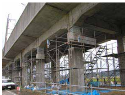
写真 2 柱機能が維持された橋脚
