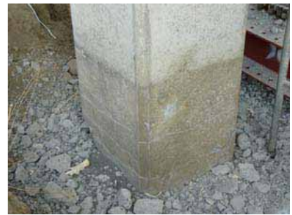
写真 3 地中部の塑性ヒンジ
