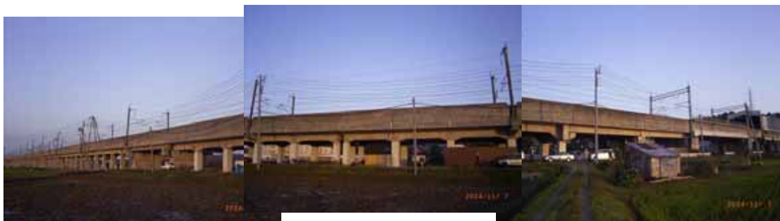
写真 1 脱線発生箇所周辺の構造形式
