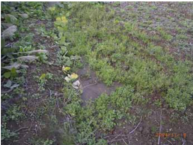
写真 4 堤内地側水田に見られた噴砂
