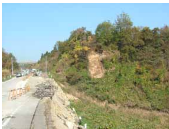
写真 2 盛土崩壊箇所 1 の状況(越後川口 IC 方向)
