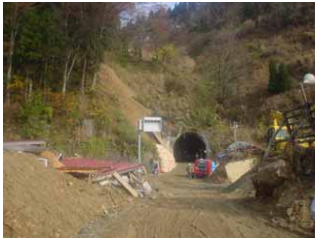
写真 1 羽黒トンネル坑口における深層崩壊
