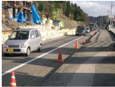
写真 1 片側相互通行の状況
