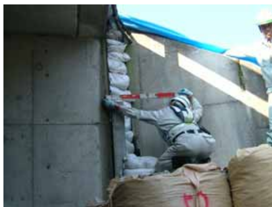
写真8 テールアルメ擁壁 C の被害状況（目地開き、背面土の流出）
