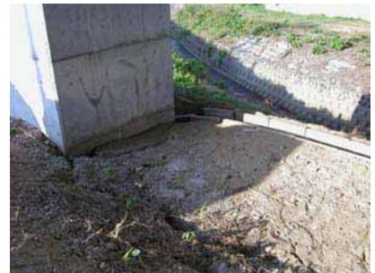
写真 3 周辺地盤の状況
