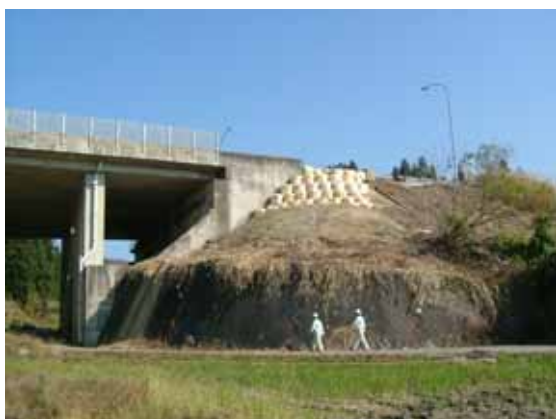
写真9 テールアルメ擁壁 C と被害状況と地山のパネル積み擁壁の縦断クラック
