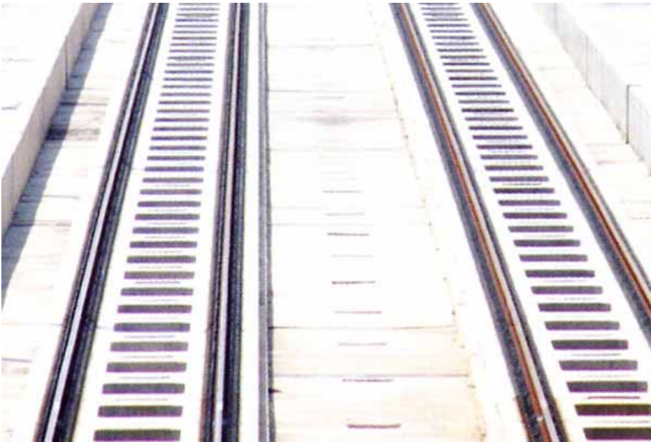
コンクリート製の連続突起
