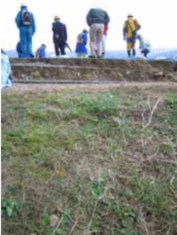
(貯水池側から堤頂を見る)
