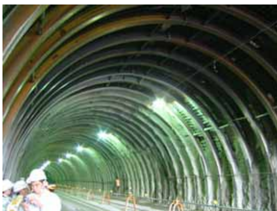
写真 3 応急復旧後の状態(崩落付近)
