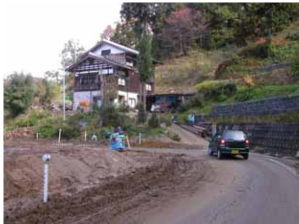
写真 6 南側崩壊箇所の背後の状況
