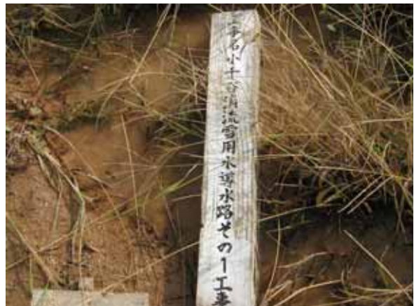
写真 2 消雪用導水路の工事表示
