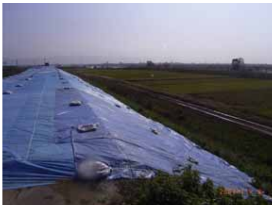
写真 3 応急復旧完了後の状況（2004 年 11 月 8 日）
