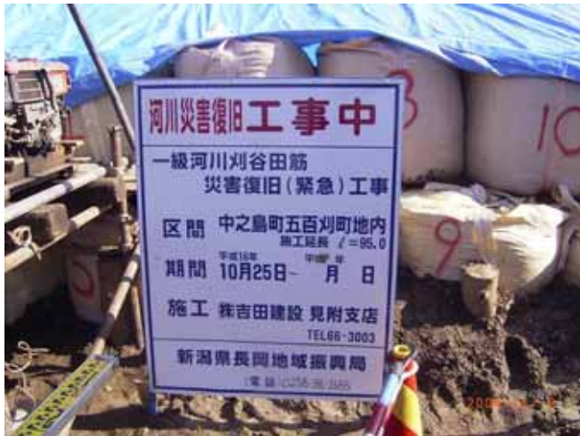
写真 3 堤防のり尻で行われていた地盤調査箇所での表示
