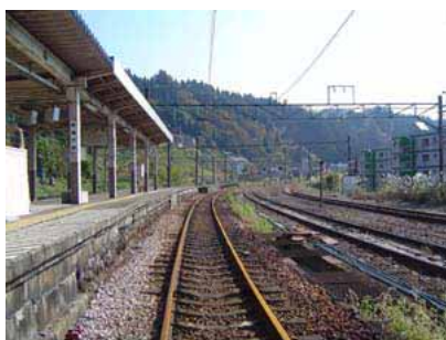
写真 2 地上部の状況
