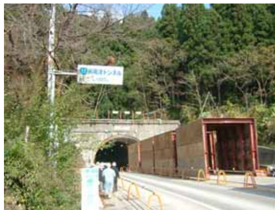
写真 2 長岡側坑口(応急復旧の支保工設置が設置されている)
