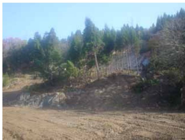
写真 2 別の岩盤すべり面
