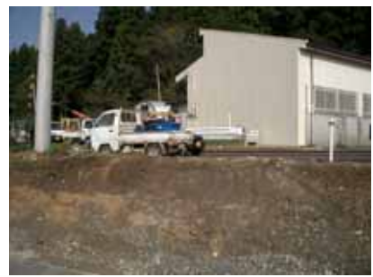
写真 3 取り壊された民間施設
