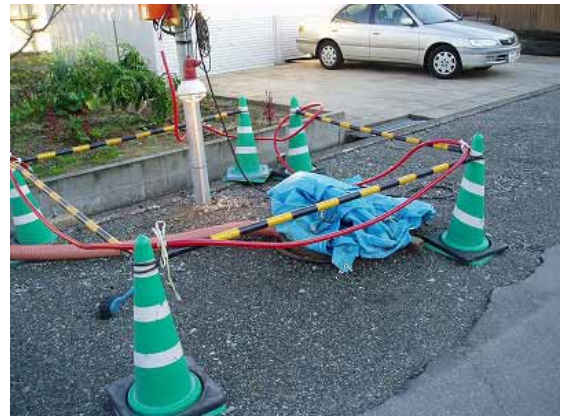
写真 6 水中ポンプが投込まれたマンホール。 下水は汲み上げられ、道路側溝を経て、 下流マンホールに導かれていた。
